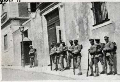
O edifício do Instituto de reeducação dos nossos soldados na Calçada de Arroios.
