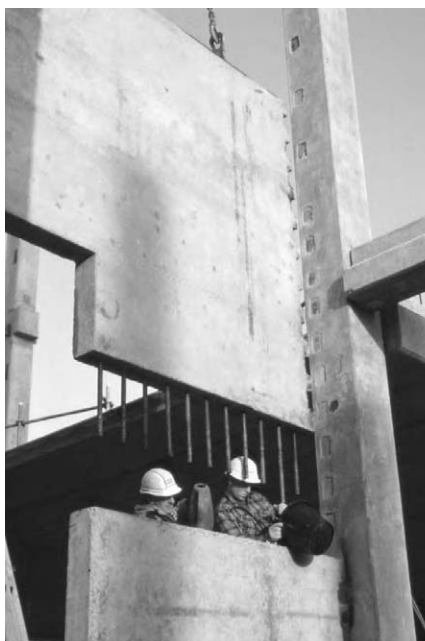
Figura 2.24: Pormenor de armaduras de continuidade salientes de uma parede [4]
