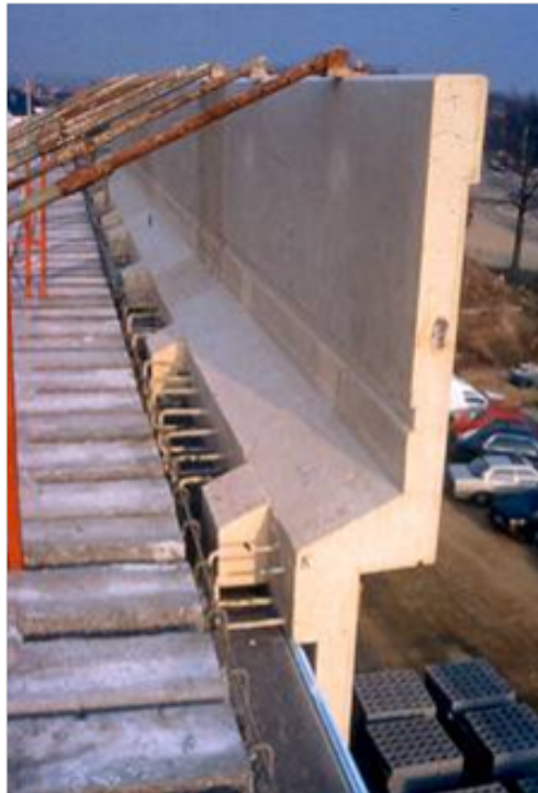
Figura 2.28: Ligação painel de fachada - laje por betonagem [34]
