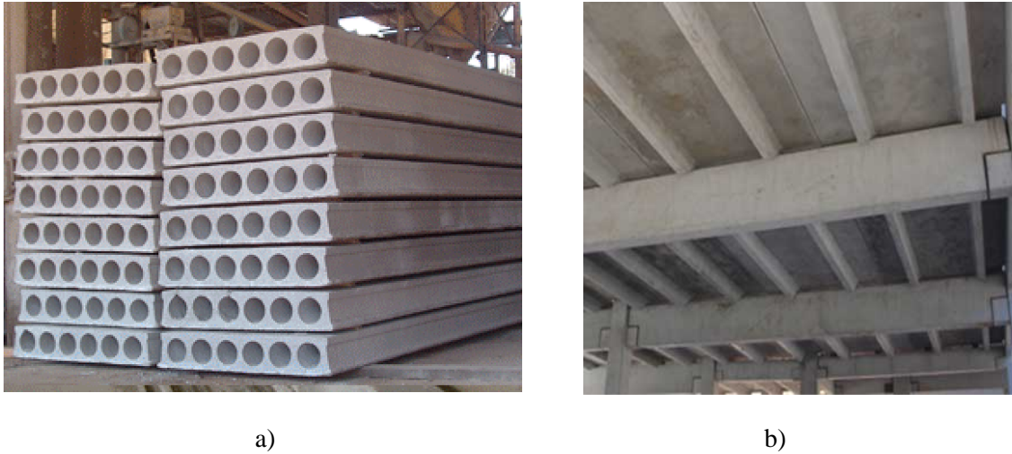
Figura 2.4: Exemplos de lajes pré-fabricadas, a) alveoladas, b) nervuradas em duplo T [25]
