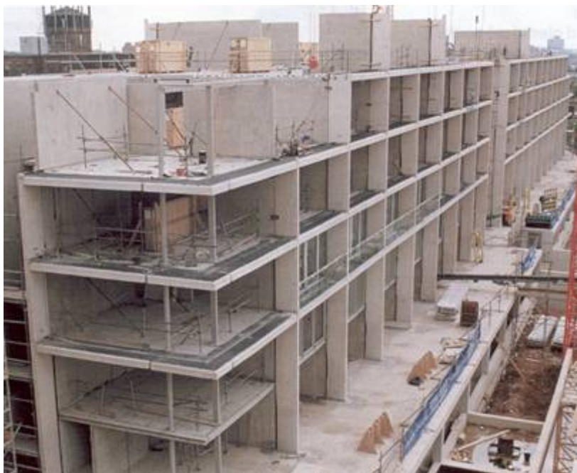
Figura 2.5: Sistema estrutural de paredes resistentes [33]
