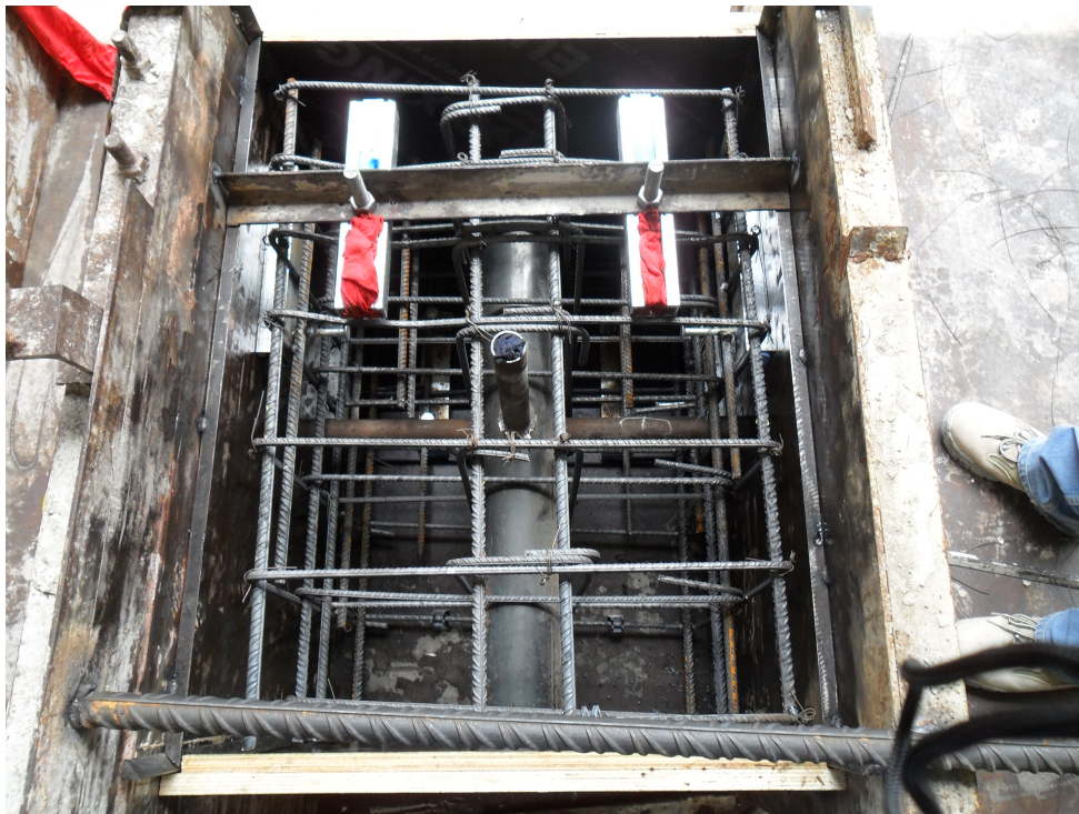
Figura A.4: Armaduras do bloco de betão
