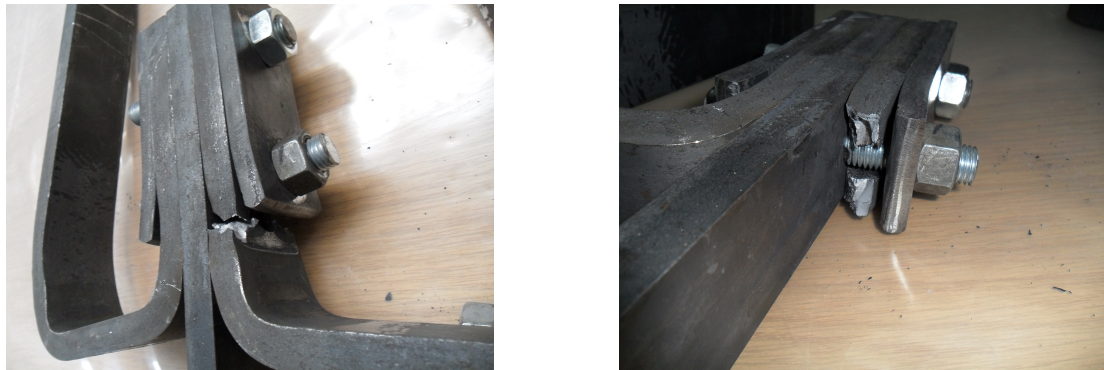
Figura 4.57: Pormenor da rotura do dispositivo pelo furo do varão inferior da ligação
