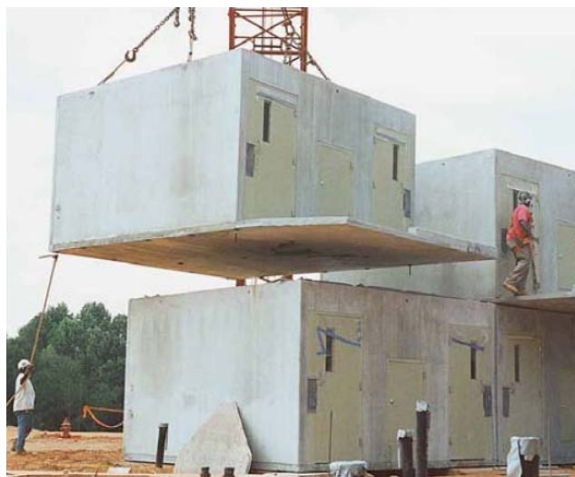
Figura 2.7: Estruturas celulares pré-fabricadas [21]
