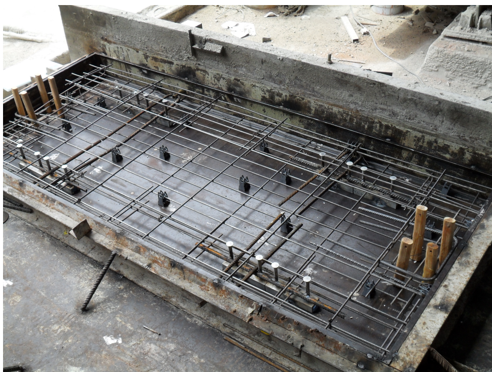
Figura A.2: Armaduras dos painéis de fachada
