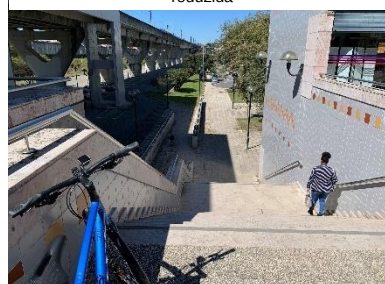
Figura 64 Percurso nº 4 - Sem acesso a mobilidade reduzida
