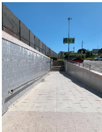
Figura 62 Túnel pedonal de acesso à estação
