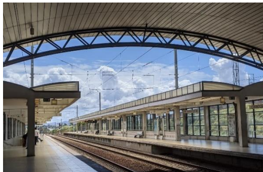
Figura 51 Plataforma superior de acesso ao comboio
