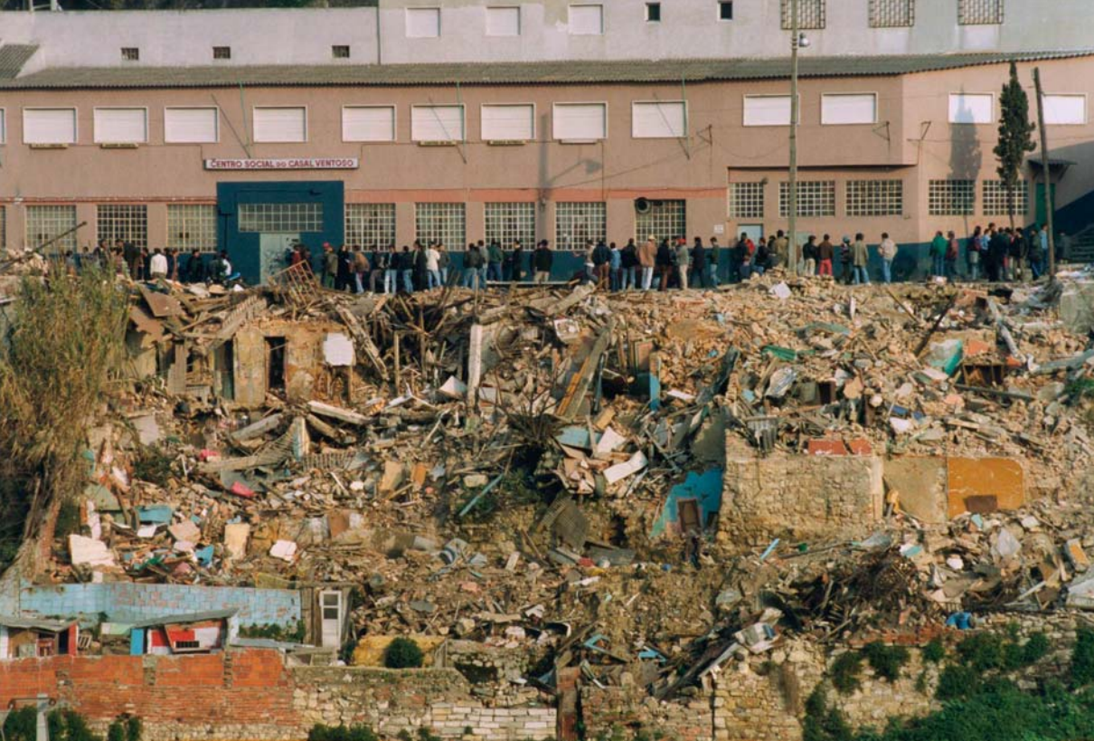
Figura 37. Casal Ventoso, com grande concentração de pessoas, em parte toxicodependentes, na fase de demolição do Bairro, com o edifício do Centro Social do Casal Ventoso ainda intacto (1999).
