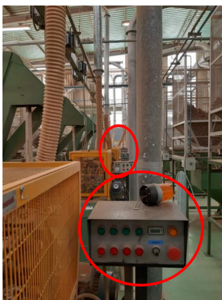
Figura 4.21 Instalação de Luzes Andon
