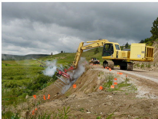
Figura 2.13: Instalação de pregagens por meio de cravação (adaptada de Launcher, 2013).
