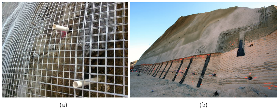
Figura 2.21: Sistemas de drenagem do revestimento do talude: a) Barbacãs (adaptada de Griffiths Drilling, 2014); b) Bandas geossintéticas (adaptada de Magazine Railroading T. T., 2013).
