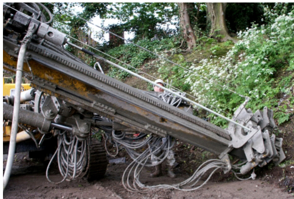
Figura 2.17: Instalação de pregagens por meio de auto-perfuração (adaptada de Weldgrip, 2011).
