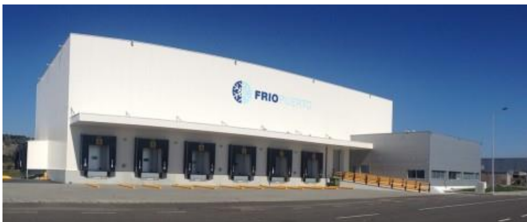
Figura 31 - Instalações da Friopuerto na ZALSines (Cadena de Sumistro, 2016)
