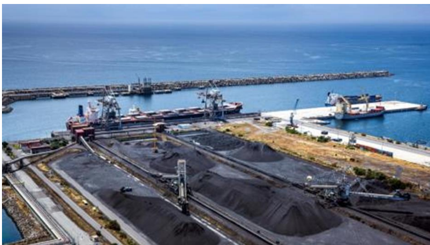
Figura 20 - Terminal Multipurpose (cortesia Administração dos Portos de Sines e Algarve, [s.d.]
