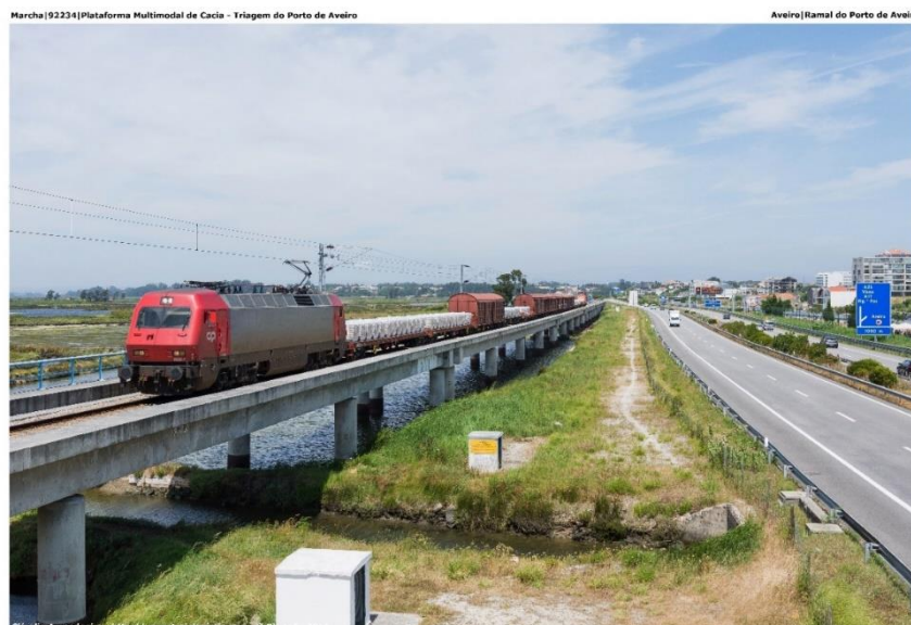
Figura 4 - Composição com tracção eléctrica a circular no Ramal de Aveiro a 29 de Junho de 2016 (Amendoeira, 2016)
