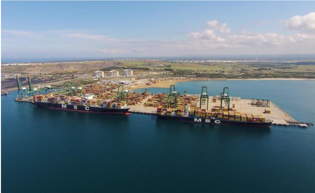
Figura 22 - Terminal de Contentores XXI (cortesia Administração dos Portos de Sines e Algarve, [s.d.]
