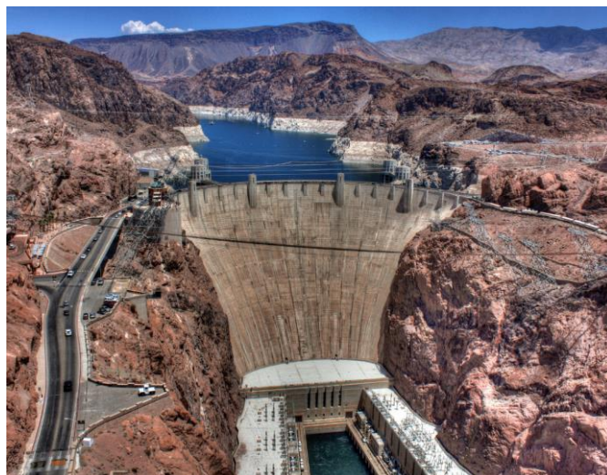
Figura 2.3 - Vista geral da barragem de Hoover (Wikipedia, 2019)
