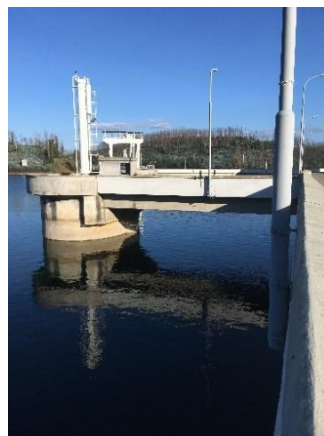
b) Torre de controlo da comporta da descarga de fundo
