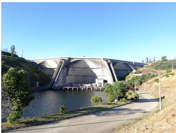
a) Vista de jusante
