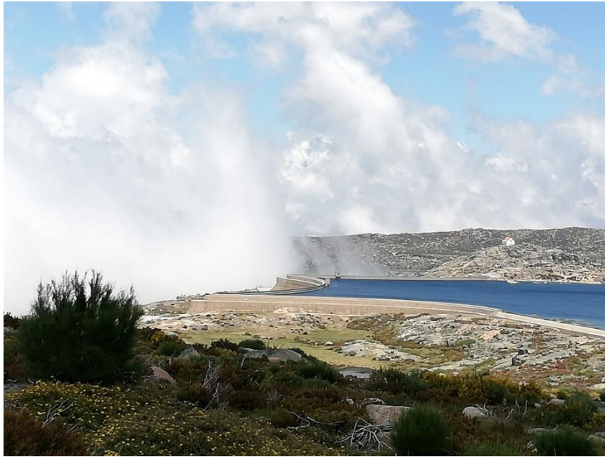
Figura 2.14 - Vista da albufeira da barragem da Lagoa Comprida
