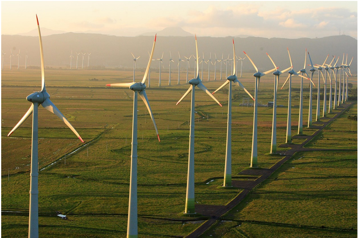
Figura 12: Plataformas de trabalho em um parque eólico Fonte: Piratini 2018
