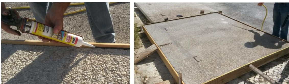
Figura 3.10- Preparação das placas de betão
