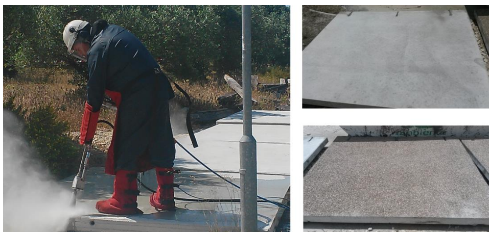
Figura 3.4- Utilização de jacto de água para criar rugosidade na superfície lisa de betão
