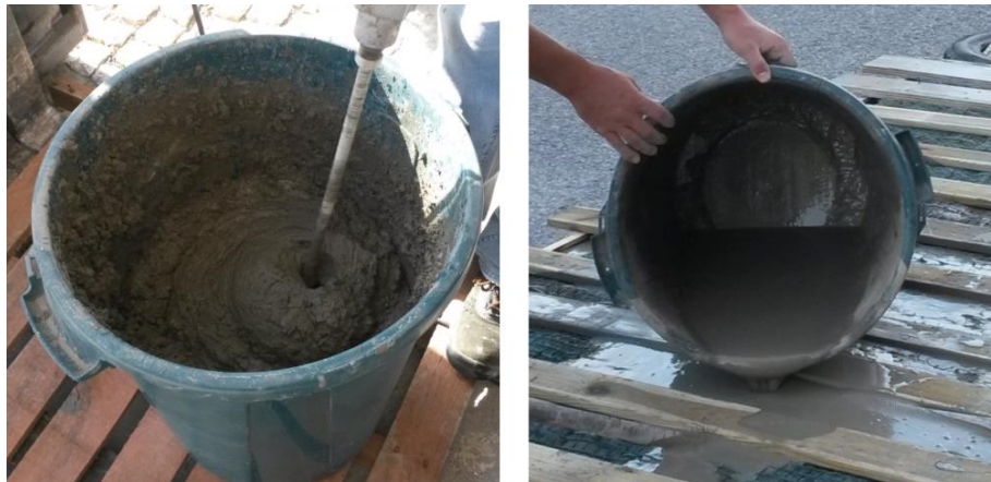
Figura 3.14- Preparação e aplicação da calda de cimento
