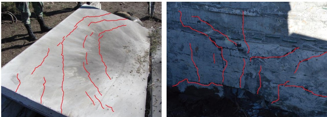
Figura 4.7- Fendilhação na placa C depois do ensaio nº2
