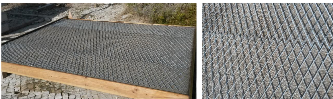
Figura 3.11- Colocação da Malha distendida
