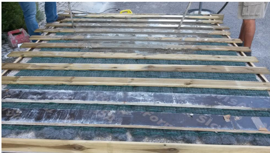
Figura 3.15- Estrutura para conter a espessura da manta de fibras
