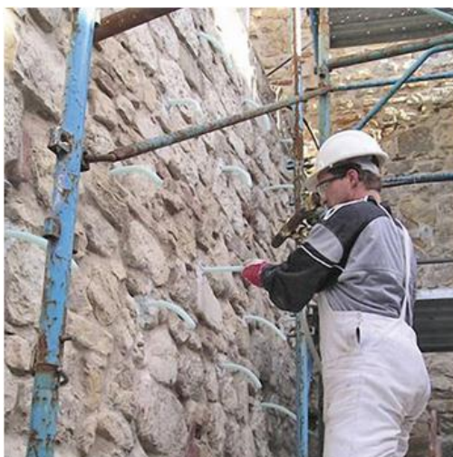
Figura 2.10 – Colocação da tubagem de injeção
