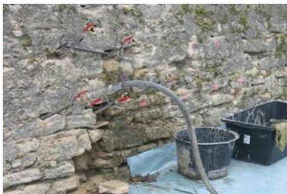
Figura 2.11 – Execução da injeção do grout
