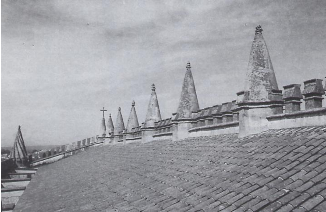
Fig. 21 – Cobertura da nave superior, após as obras de restauro.
