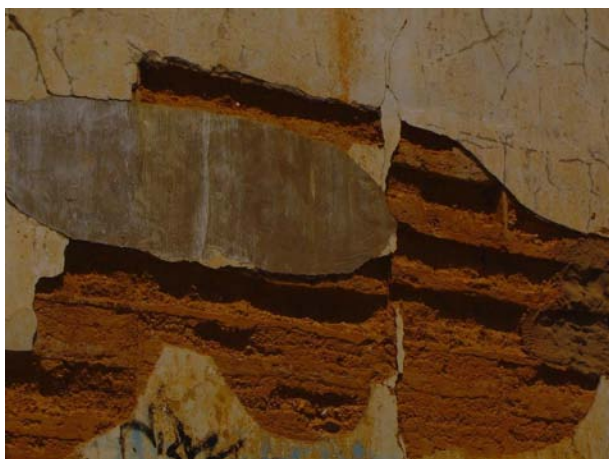
Fig 2.29 – Reparação com reboco à base de cimento, numa parede em terra.
