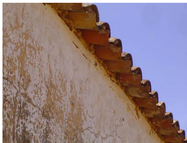
Fig 3.44 - Beirado da fachada posterior, mais simples.
