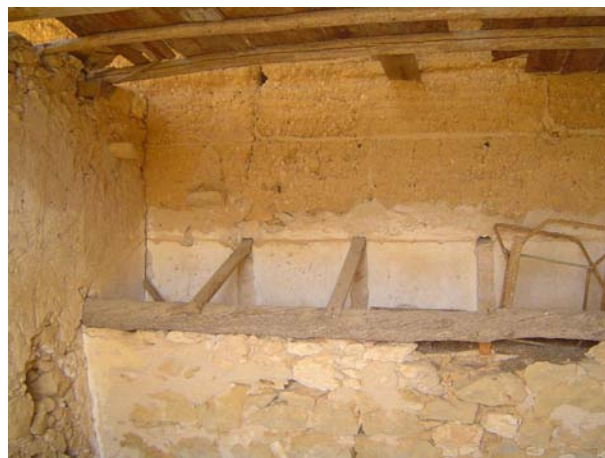
Fig 3.8 – Manjedoura em alvenaria de pedra, com estrutura da cobertura em madeira.
