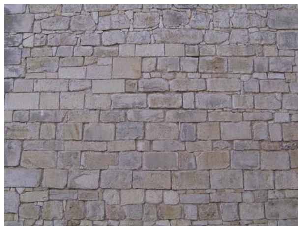
Fig 2.34 – Alvenaria de pedra aparelhada, muralhas do Castelo de Loulé.
