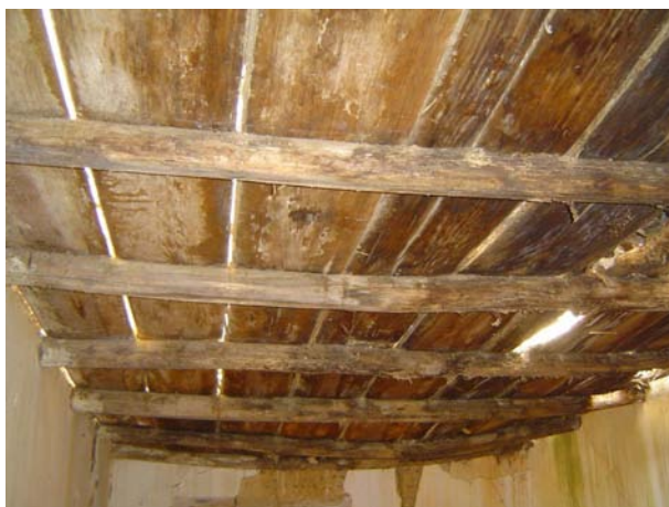
Fig 3.45 – Pavimento interior, para criação de sobrado.
