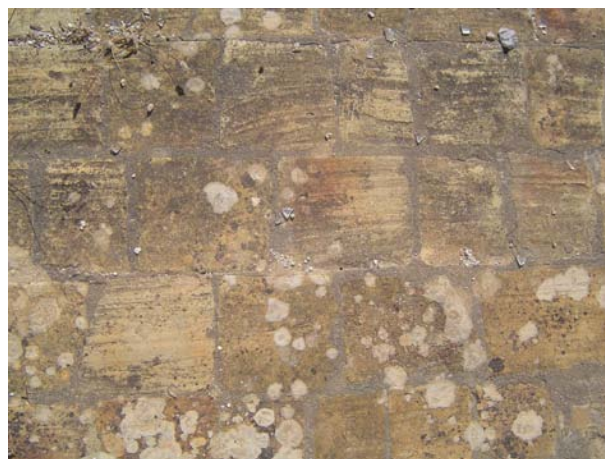
Fig 3.92 – Pavimento exterior, em material sem geometria, aproveitado de desperdícios.
