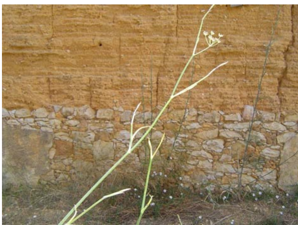
Fig 3.15 – Embasamento de paredes exteriores, em pedra local, não aparelhada.
