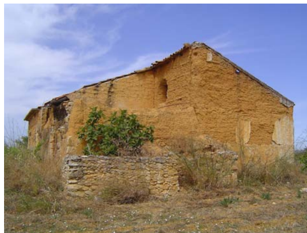
Fig 3.2 – Fachada lateral da edificação de pequeno porte em taipa.
