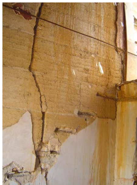
Fig 3.6 - Vestígios de escada na cozinha, encastrada na parede exterior em taipa.
