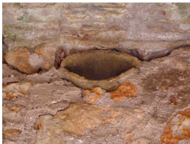
Fig 3.106 – Aspecto interior da abertura para ventilação.
