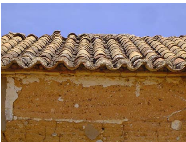
Fig 3.43 - Beirado da fachada principal, com as telhas argamassadas.
