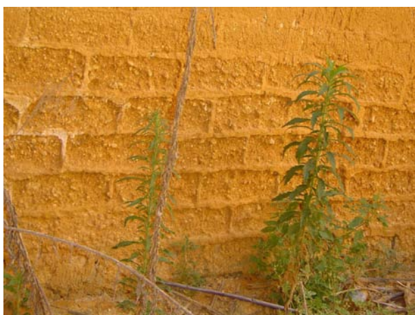
Fig 3.17 – Parede interior em alvenaria de adobe assente directamente no pavimento.
