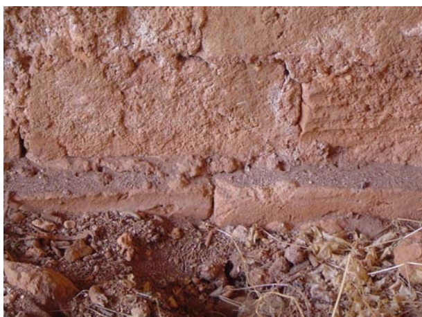
Fig 3.97 – Embasamento em tijolo a “meia vez”, para assentamento das paredes interiores.
