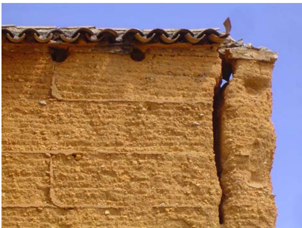
Fig 2.25 – “Descolamento” entre paredes exteriores ortogonais.
