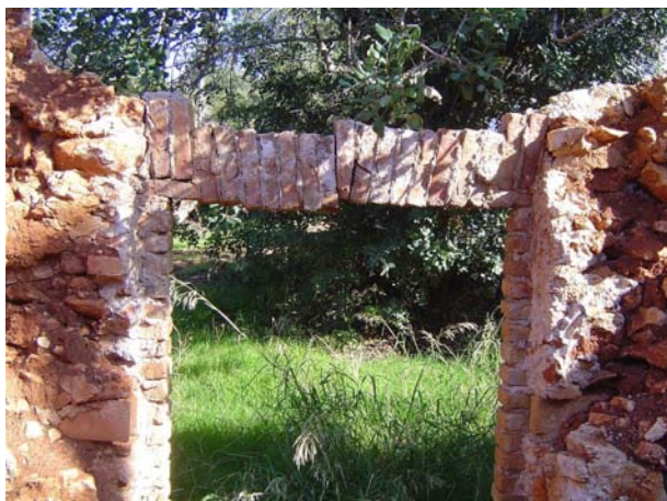
Fig 3.111 – Tijolos cerâmicos da verga da porta das traseiras, que se mantêm.
