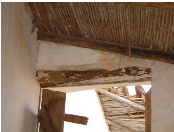
Fig 3.73 – Verga de madeira em porta interior, com alguma perda de secção.
