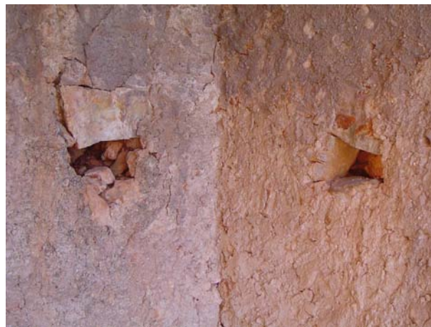
Fig 3.102 – Locais de suporte da estrutura de madeira.
