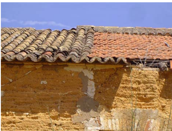
Fig 3.39 - Diversidade de telhas aplicadas, entre canudo e Marselha.
