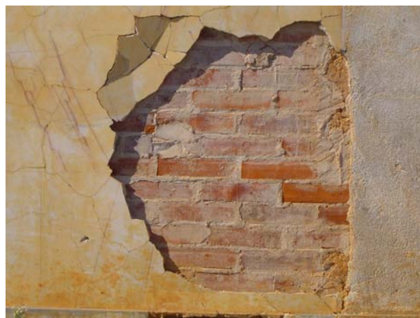
Fig 2.30 - Destaque do revestimento, numa alvenaria de tijolos cerâmico maciço.
