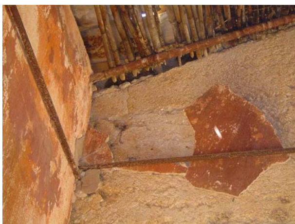
Fig 3.23 – Fixação das extremidades dos tirantes de aço, com argamassas cimentícia
