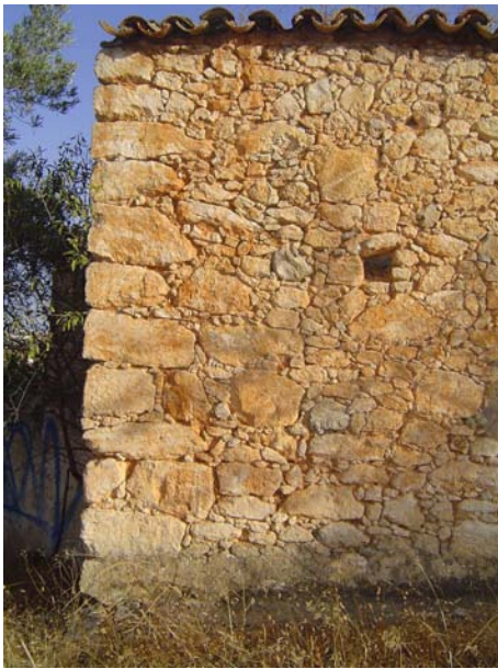
Fig 3.65 - Cunhais de parede exterior localizada nas traseiras, sem revestimento.
