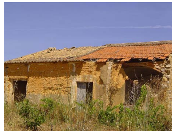
Fig 3.40 – Vista geral da cobertura com aplicação de diferentes materiais de revestimento.
