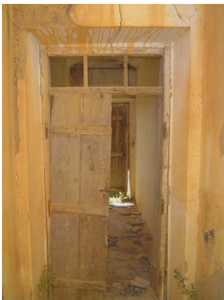
Fig 3.29 - Vão interior em madeira, com bandeira para permitir a passagem de luz.
