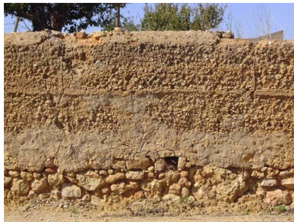
Fig 2.24 – Muro de vedação em taipa, com base de pedra.
