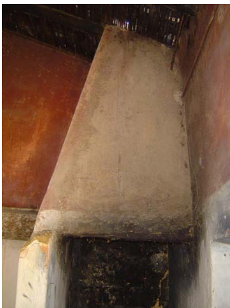
Fig 3.5 - Chaminé da cozinha, onde os alimentos eram cozinhados a lenha.
