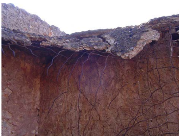
Fig 3.115 – Malha de aço da cobertura, formada por cabos usados nas amarrações navais.
