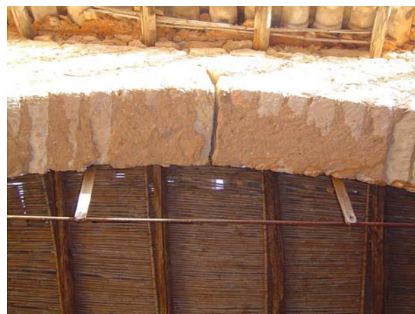
Fig 3.76 - Reforço metálico do arco em pedra.
