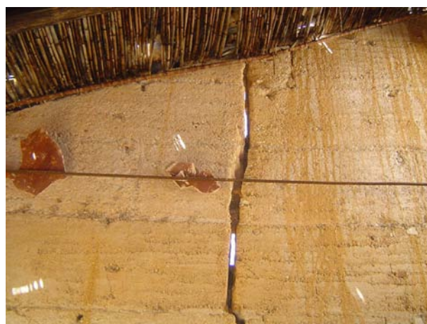
Fig 3.24 - Reforço estrutural recorrendo a tirantes em aço, em locais de elevada fissuração.
