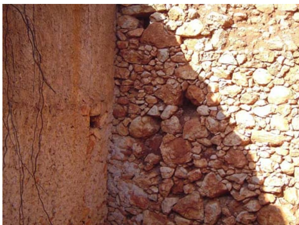
Fig 3.95 – Paredes exterior em pedra não aparelhada.
