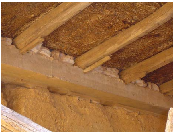
Fig 3.41 - Reforço executado por lintel em betão, sobre a parede em taipa.
