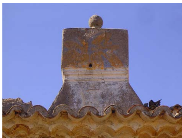
Fig 3.50 - Chaminé datada de 1869, ano provável da edificação.
