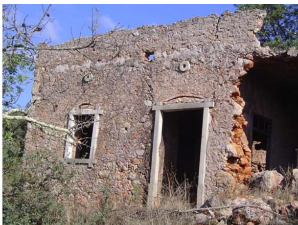
Fig 3.109 – Cantarias da fachada principal, no contorno dos vãos.
