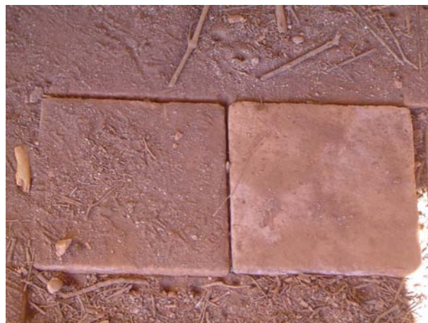
Fig 3.124 – Pormenor do pavimento interior, em ladrilhos cerâmicos.
