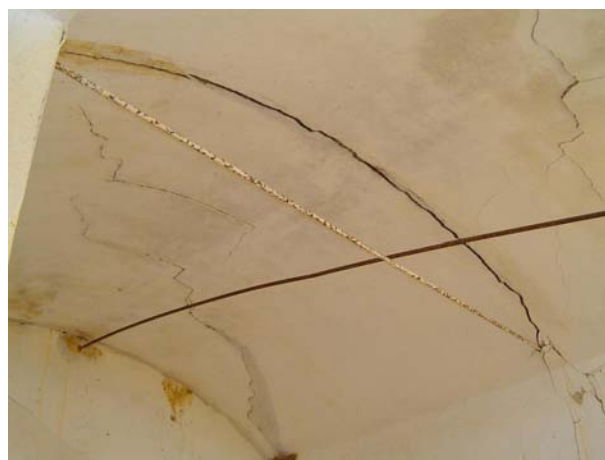
Fig 3.34 - Reforço estrutural nos dois sentidos, na cobertura em abóbada da sala.
