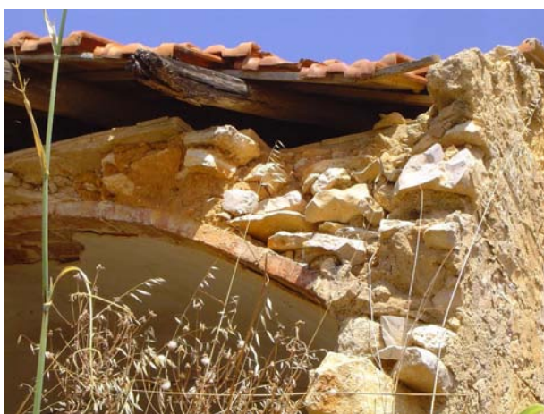
Fig 3.35 – Elementos constituintes da cobertura em abóbada.
