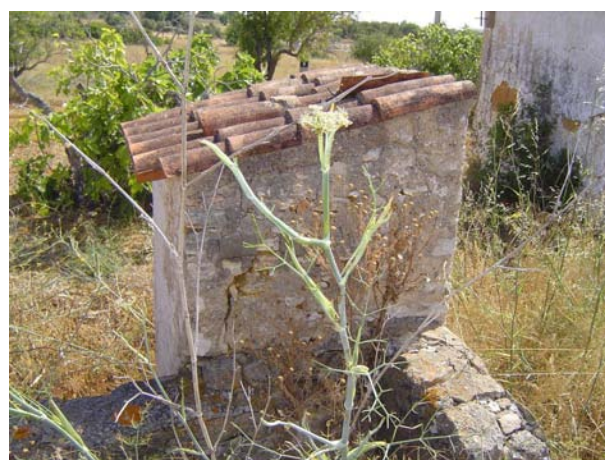
Fig 3.10 – Anexo à habitação principal, que deveria servir de instalação sanitária.
