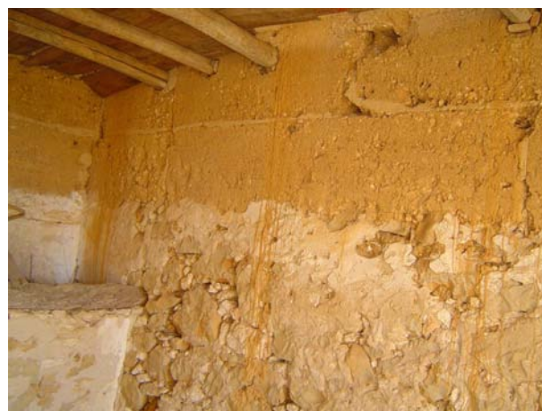
Fig 3.16 – Paredes exteriores com execução dos blocos de taipa, sobre a base em pedra.
