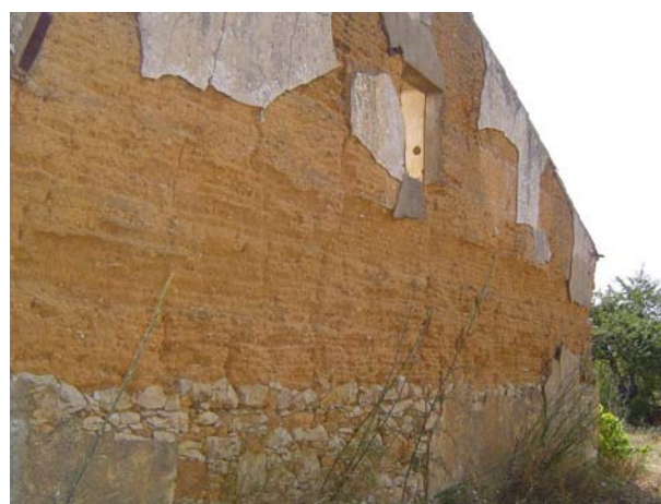
Fig 3.12 - Pared exterior do lado Sudoeste em taipa, com embasamento de alvenaria de pedra.
