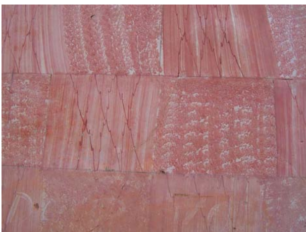
Fig 2.27 – Revestimento exterior pintado, com pigmentos coloridos.
