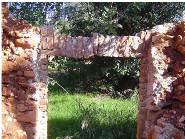
Fig 2.31 – Verga em tijolo cozido, sendo visível a pedra de fecho.
