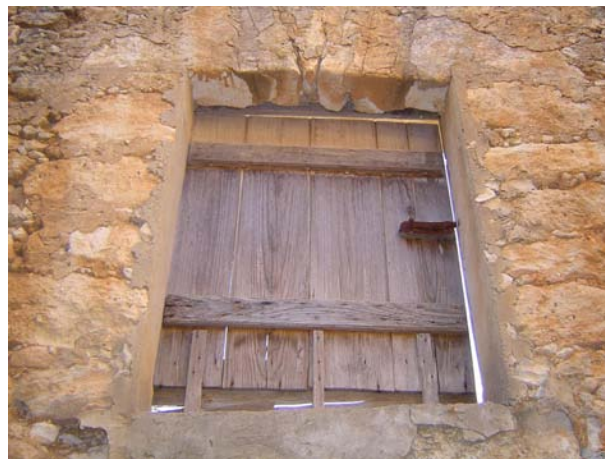
Fig 3.74 – Verga de vão exterior, formada por pedras de maiores dimensões.
