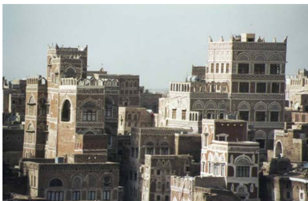
Fig 2.9 – Edifícios da cidade de Sanaa, construídos em adobe e decorados a branco [9]
