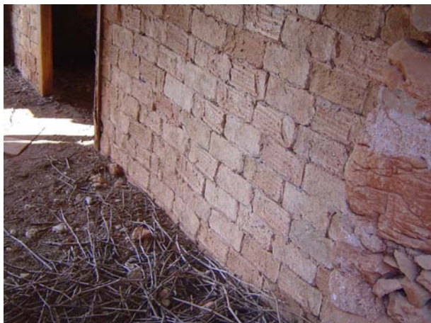
Fig 3.99 – Parede interior em tijolo tradicional.
