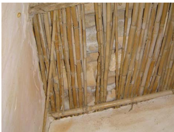
Fig 3.81 - Assentamento das telhas directamente na esteira de canas.
