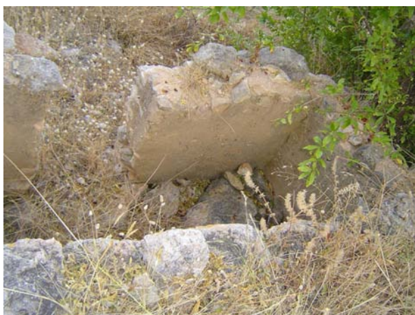
Fig 3.57 - Pocilga das traseiras, em pedra como toda a habitação.
