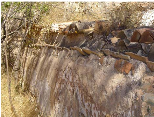
Fig 3.87 – Aspecto da caleira na fachada posterior, para recolha da água da chuva.
