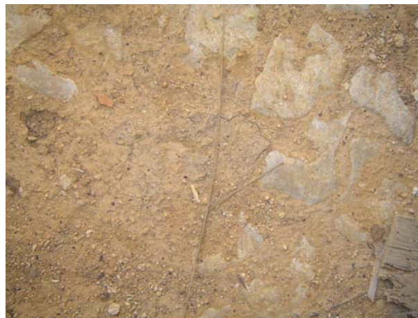
Fig 3.48 – Pavimento em pedra, na zona de ocupação por animais.
