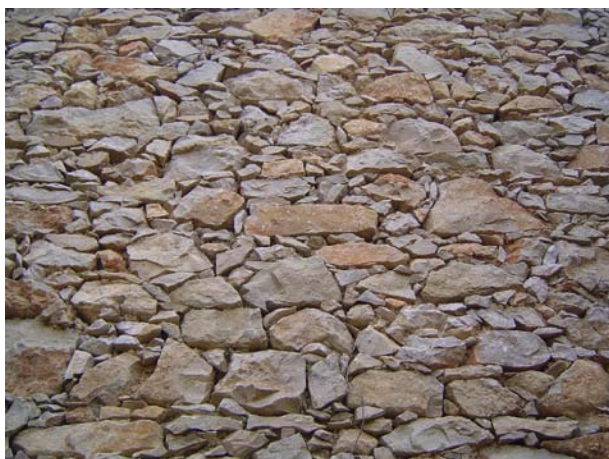
Fig 2.33 – Alvenaria de pedra sem aparelhamento, com junta argamassada.
