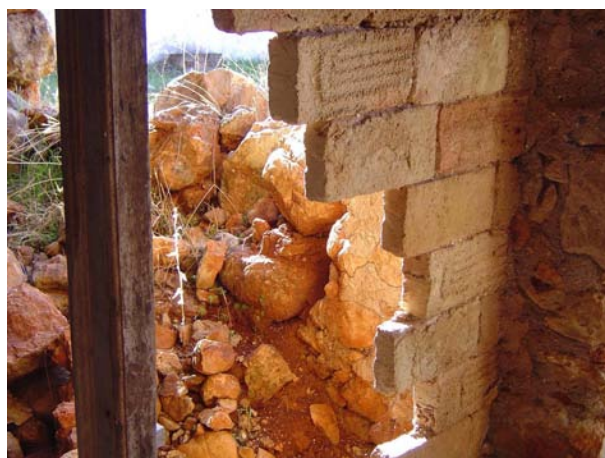
Fig 3.98 – Ligação entre paredes interiores e exteriores.
