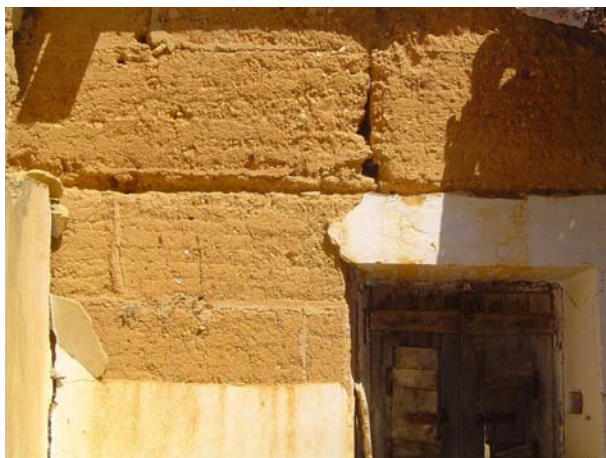
Fig 3.7 – Parede exterior das traseiras, com blocos de grande dimensão em taipa.
