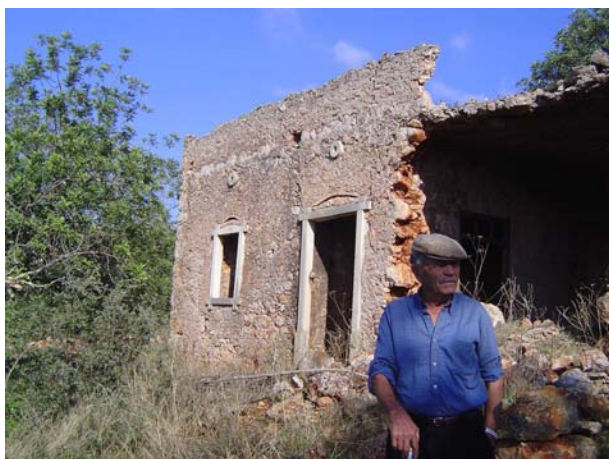
Fig 3.93 – Sr. Casemiro na fachada principal da construção, na freguesia de Tôr.
