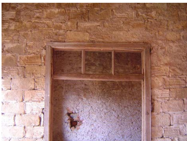
Fig 3.113 – Guarnições de portas interiores, com bandeira.
