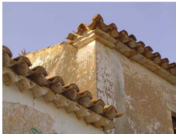
Fig 3.86 - Diferentes arquitecturas entre beirado do piso térreo e do piso superior.
