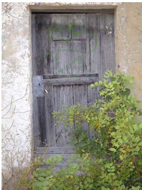
Fig 3.71 - Porta da fachada em madeira, com postigo.
