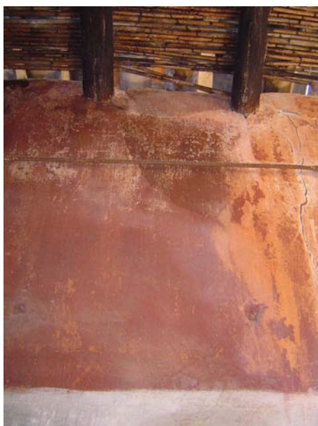
Fig 3.21 - Paredes da cozinha de cor vermelha, devido aos pigmentos adicionados.
