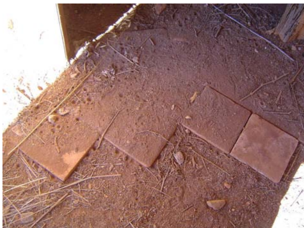
Fig 3.123 – Assentamento de pavimento interior, em ladrilhos cerâmicos.
