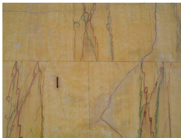
Fig 2.28 – Revestimento exterior da fachada principal.
