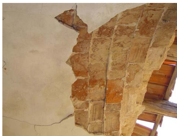
Fig 3.36 – Cobertura da sala em abóbada de um arco abatido.
