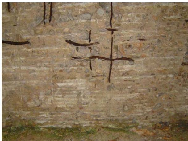
Fig 3.121 – Marcas da esteira de canas, verificadas nos tectos interiores.
