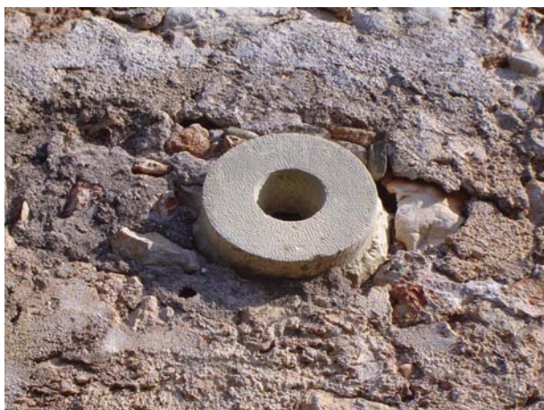
Fig 3.105 – Abertura para ventilação, lado exterior.
