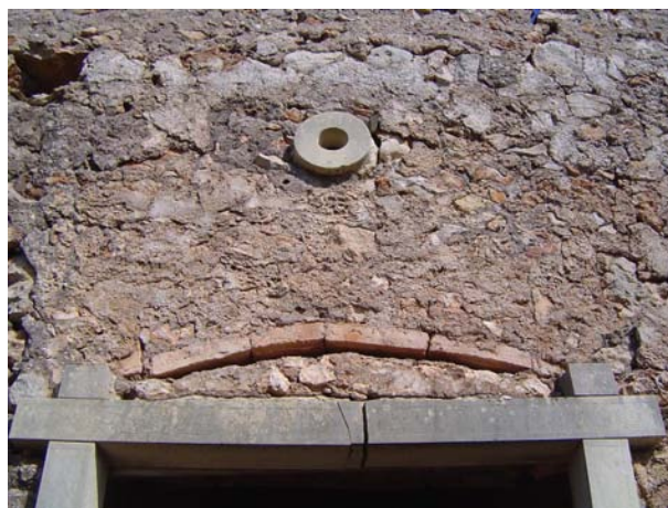
Fig 3.110 – Reforço da verga da porta, com recurso a tijolos em arco.
