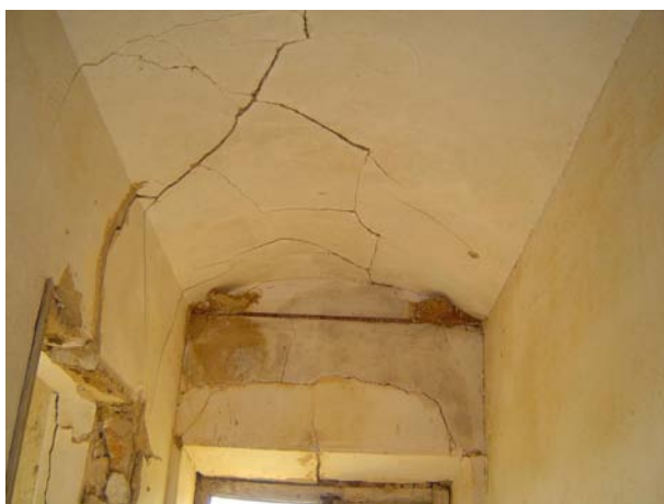
Fig 3.33 - Reforço estrutural da cobertura em abóbada, na zona da entrada.
