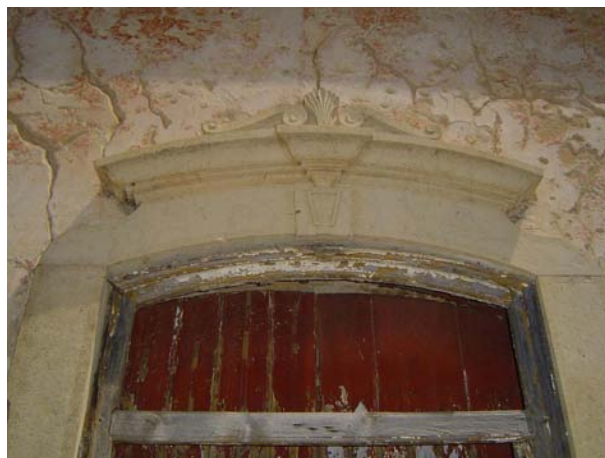
Fig 2.32 – Cantaria decorativa em vão exterior, com resistência estrutural.
