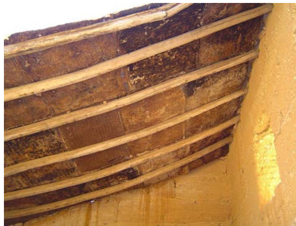
Fig 3.42 – Substituição da esteira em canas por chapas metálicas.
