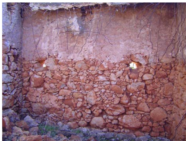
Fig 3.96 – Alvenaria de pedra, apenas com revestimento na parte superior.
