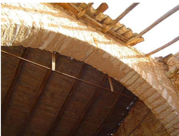
Fig 3.75 - Arco em pedra, elemento construtivo único nesta edificação.
