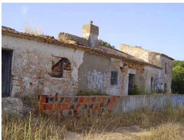
Fig 3.49 - Fachada principal da construção em pedra.
