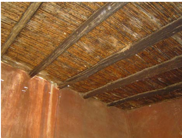
Fig 3.37 - Cobertura da cozinha, em caniço sobre barrotes, com terras a revestir.
