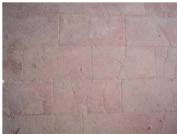
Fig 3.90 – Aplicação do pavimento alinhado lado a lado, com juntas desencontradas.
