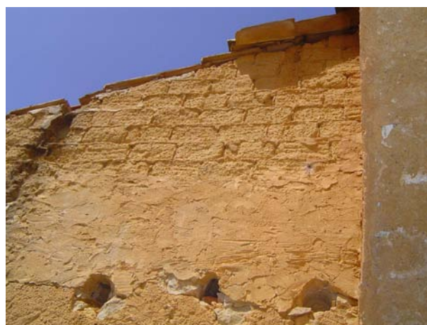
Fig 3.18 – Parede interior de adobe, assente em alvenaria de pedra.
