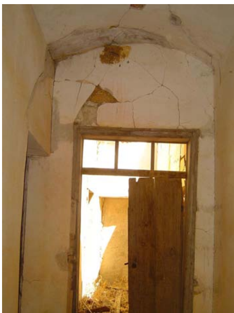
Fig 3.3 - Entrada principal com cobertura em abóbada de arco simples.
