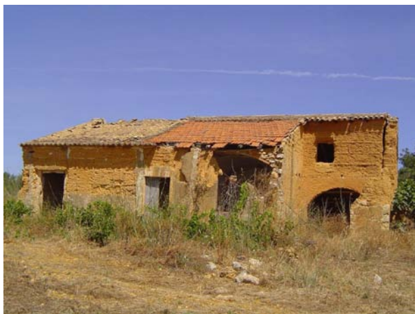
Fig 3.1 – Fachada principal virada a Sudeste, da construção de taipa.
