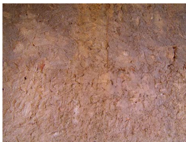
Fig 3.104 – Face interior de parede exterior com salpico em bruto.
