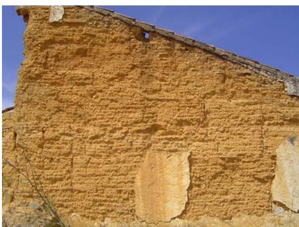
Fig 3.11 - Pared exterior do lado Nordeste, executada em blocos de taipa.
