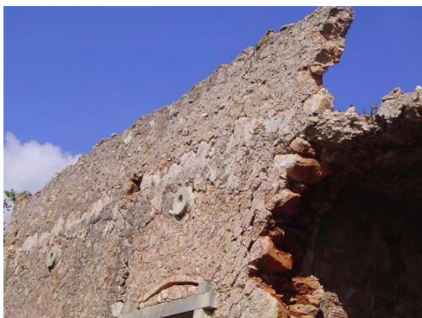
Fig 3.107 – “Amparo” da fachada principal, com abertura para escoamento da água da chuva.
