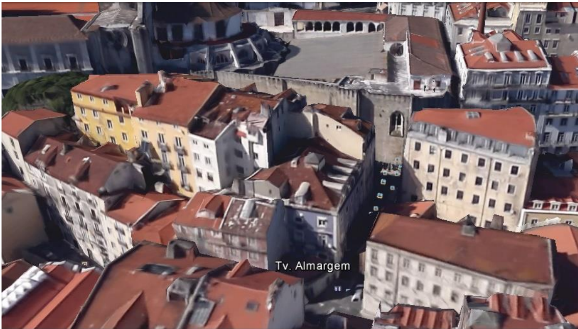
Figura 4.2 – Vista panorâmica da envolvente da Travessa do Almargem (Google Earth, 2017)
