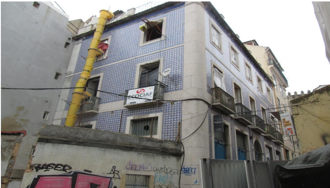
Figura 4.1 – Vista geral do edifício (Travessa do Almargem)
