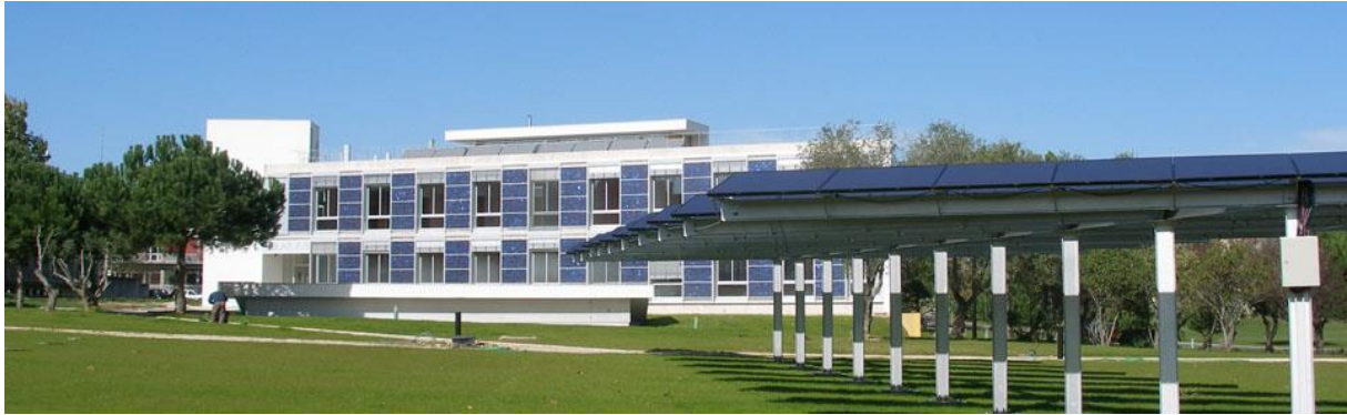
Figura 3.8 – Cobertura do estacionamento («LNEG - Laboratório Nacional de Energia e Geologia», 2010b)
