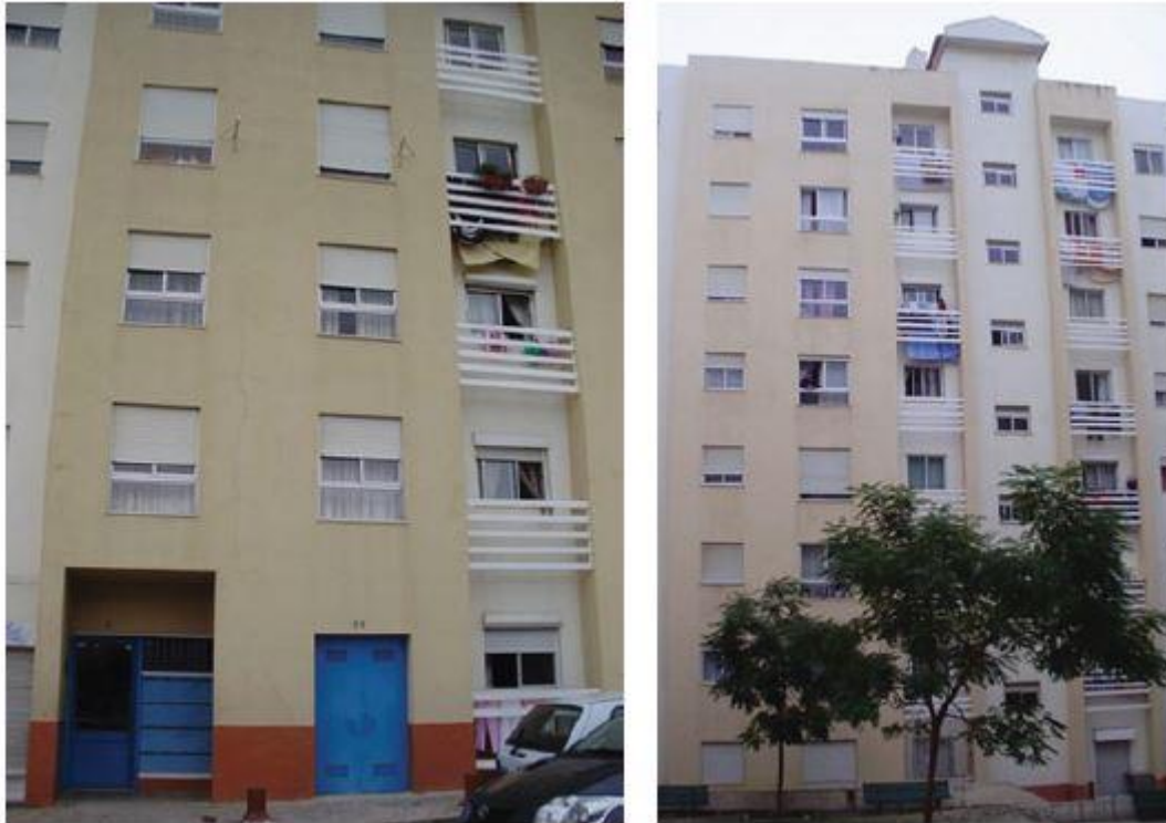
Figura 3.3 – Vista geral do edifício (Lisboa E-Nova - Agência Municipal de Energia-Ambiente de Lisboa & Edifícios Saudáveis Consultores, 2010)
