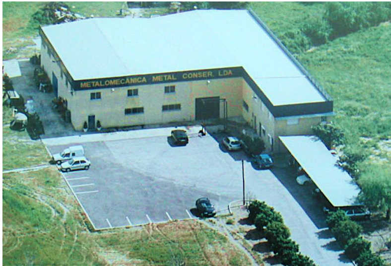
Figura 2 - Instalações Metal - Conser, Lda
