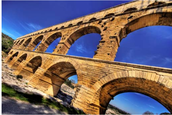
Figura 4 - Exemplo de construção romana: Pont du Gard, sul de França.
