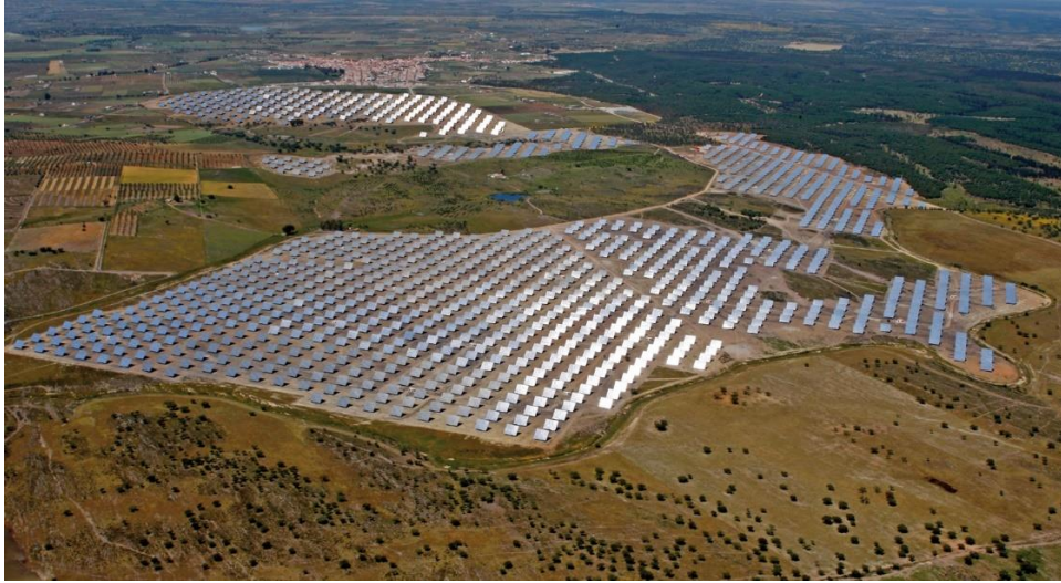
Figura 2.7 - Central Solar FV de Amareleja com sistema de seguimento solar [10].
