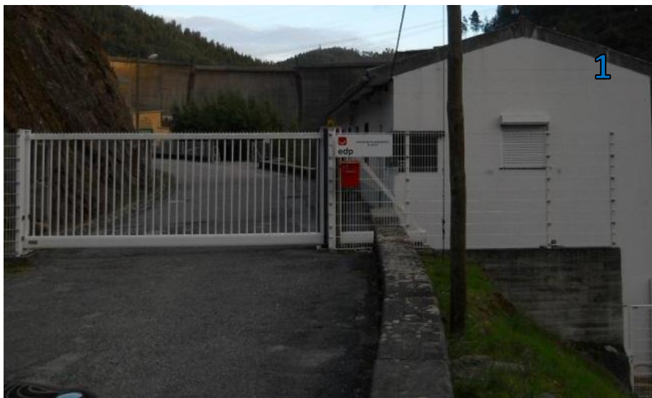
Figura 5 – Aproveitamento Hidroelétrico da Barragem da Bouça
