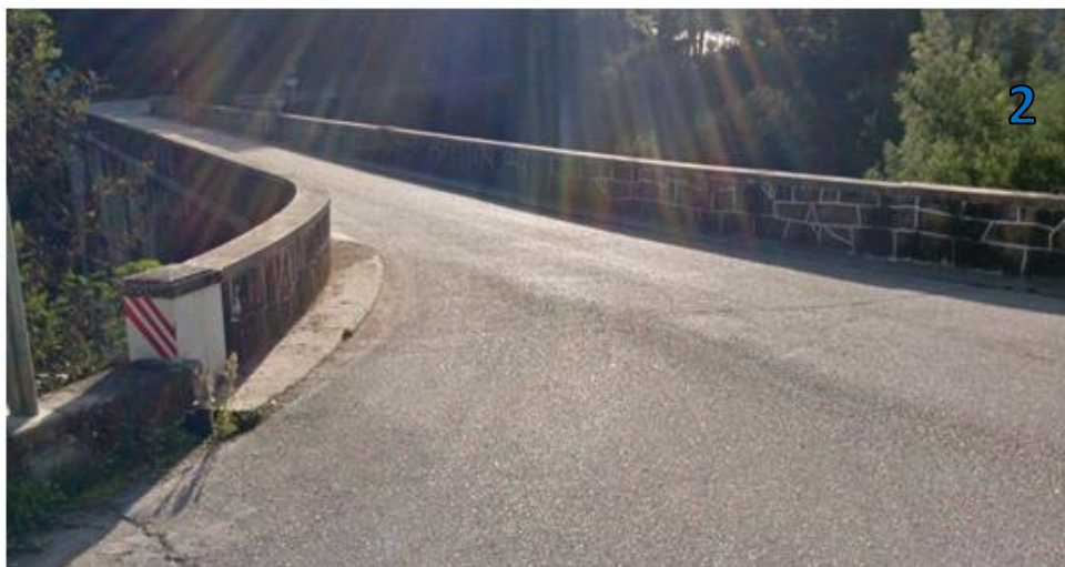
Figura 6 – Ponte da Bouça na EN237
