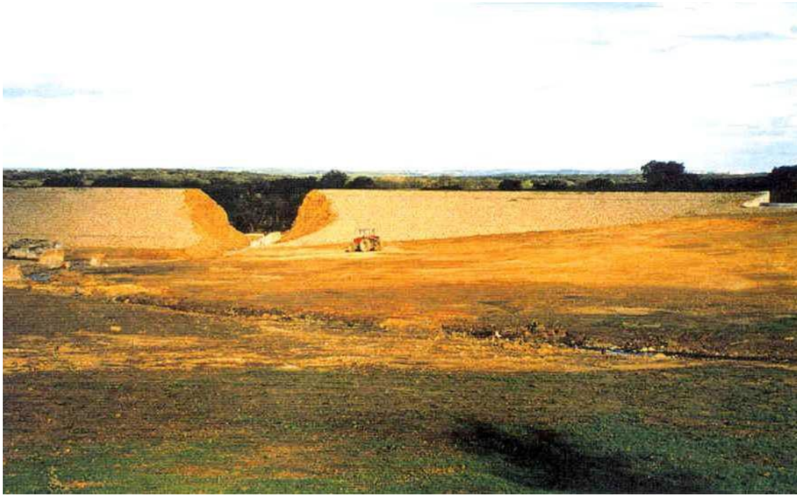
Figura 2 - Aspecto da ruptura da barragem dos Hospitais, Évora (Sá, 2007)
