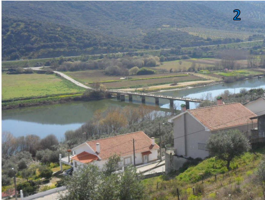
Figura 9 – Ponte sobre o Rio Sabor
