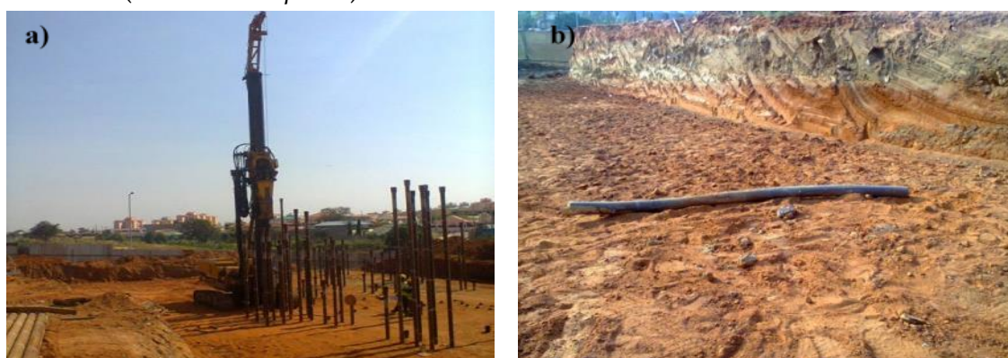
Figura 1.5 – a) Empreitada de cravação de estacas dúcteis em Luanda: vista geral; b) aspeto de uma estaca após encurvadura
