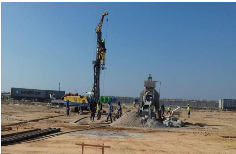
Figura 4.18 – Vista para Leste da obra do Hospital do Cuíto
