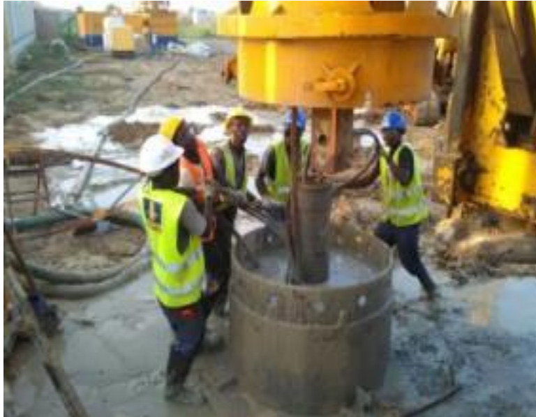
Figura 4.8 – Operação de corte do “tremie” na obra Parque Tecnológico da Camama
