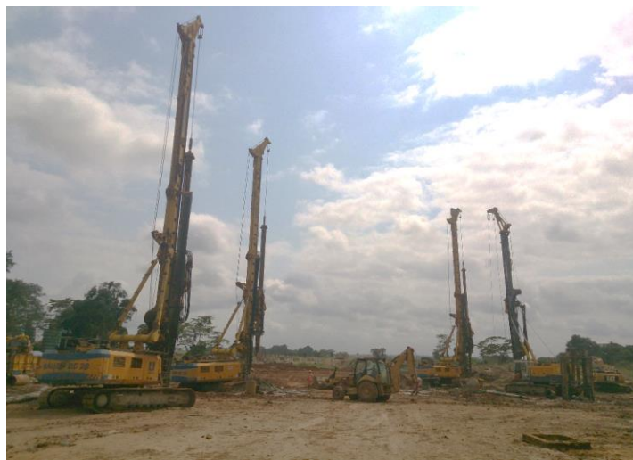
Figura 2.5 – Vista geral da empreitada de estacas moldadas com vara “Kelly”
