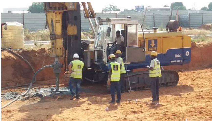
Figura 4.17 – MBG 12 na cravação de estacas dúcteis injetadas na obra do edifício habitacional no Zango
