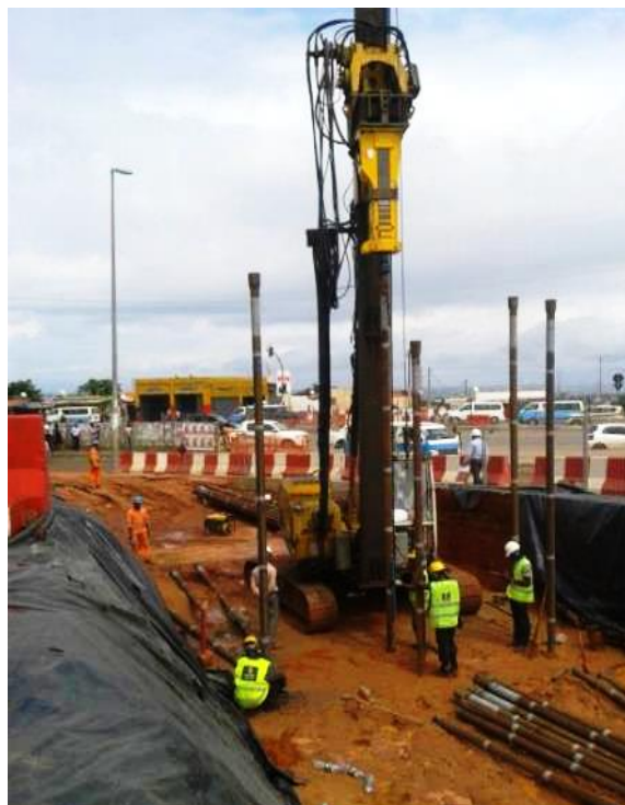
Figura 4.16 – Vista para Norte da construção dos Viadutos sobre a Via Expressa
