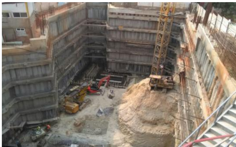
Figura 4.9 – Vista geral, para noroeste da contenção do Edifício em Alvalade
