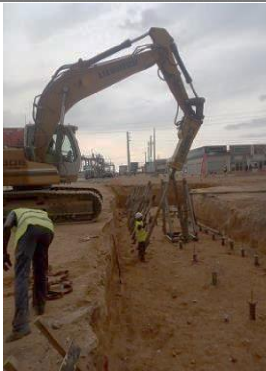
Figura 2.18 – Cravação de estacas dúcteis inclinadas, não injetadas
