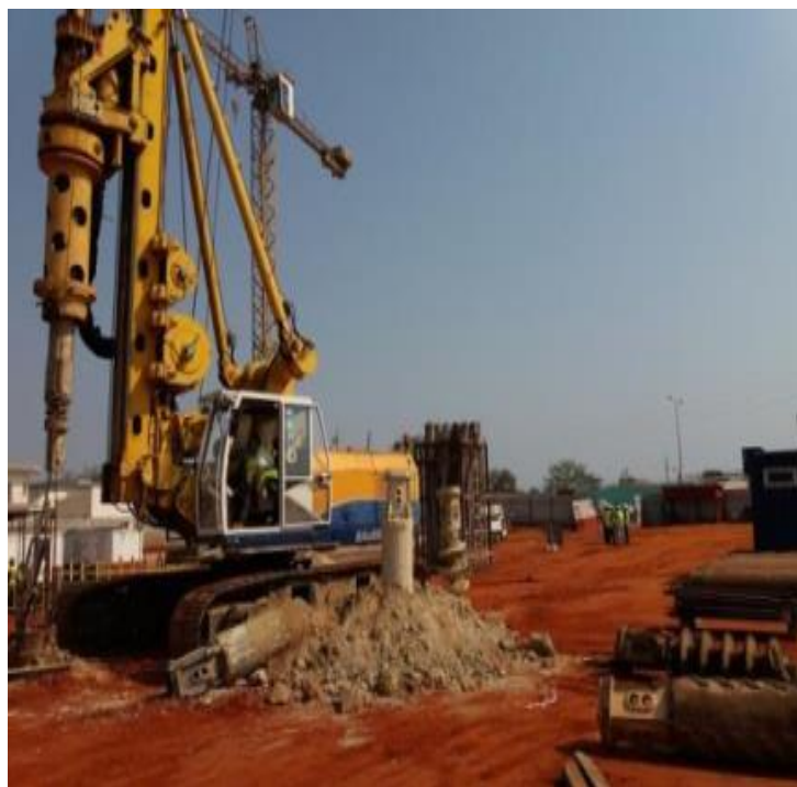
Figura 4.10 – Vista para Sul da obra Centro de formação Benfica
