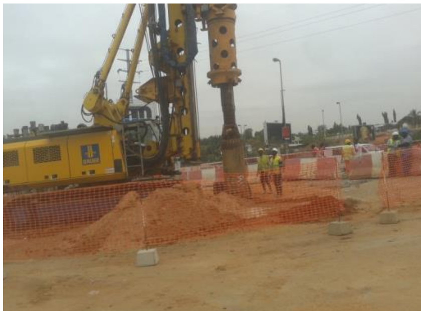
Figura 4.14 – Vista para Leste da construção do Viaduto da Corimba
