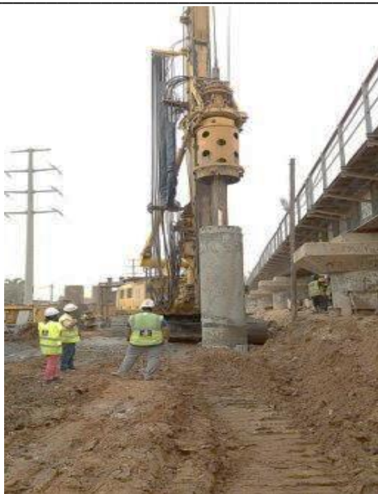
Figura 4.13 – Vista para Oeste da construção da Ponte metálica da Boavista
