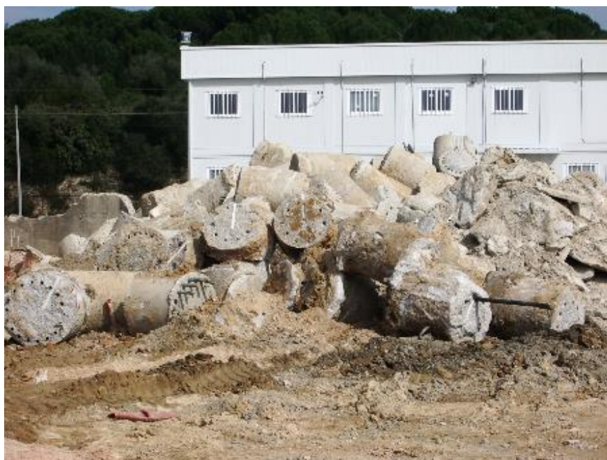
Figura 2.35 - Aspeto da cabeça das estacas, demolidas para aproveitamento como “rip-rap”
