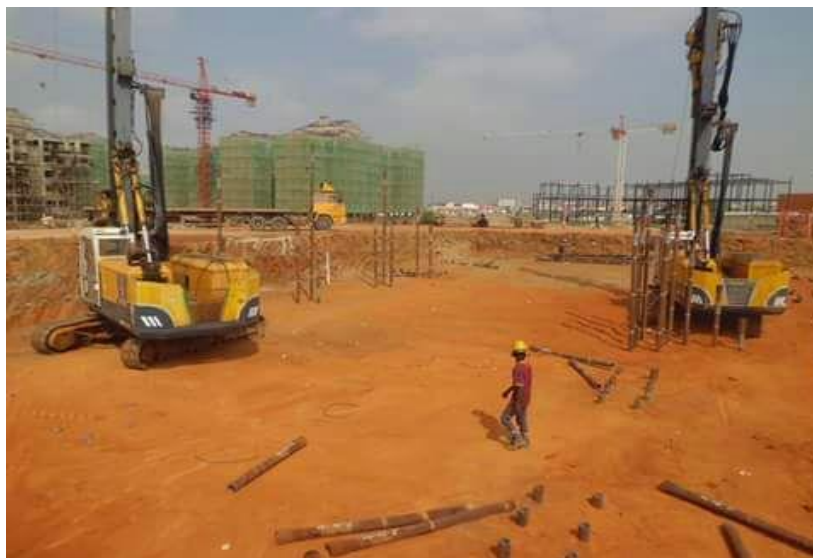
Figura 4.19 – Vista para Leste da obra Empreendimento Nova Vida
