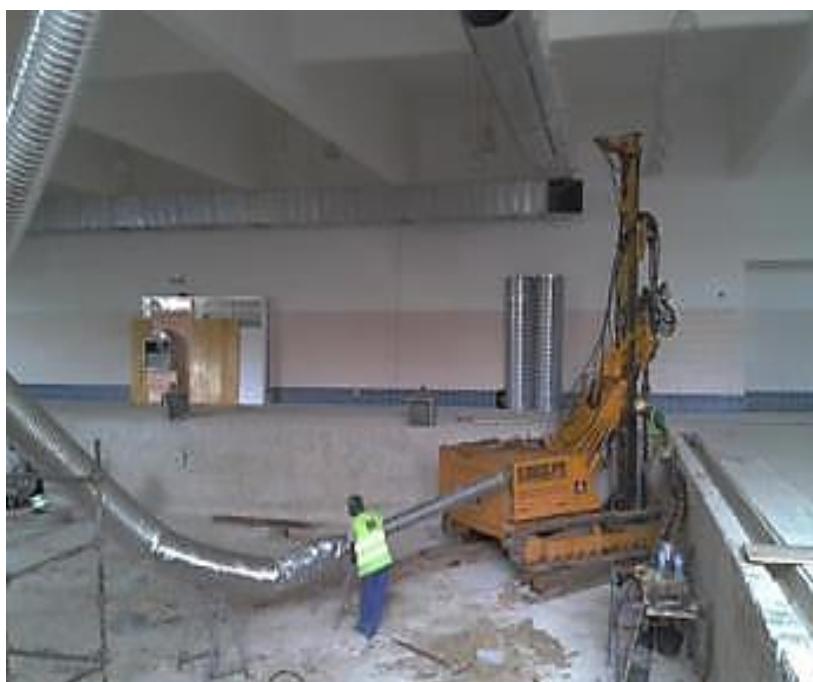
Figura 2.27 – Máquina perfuradora de pequeno diâmetro, UBW 06
