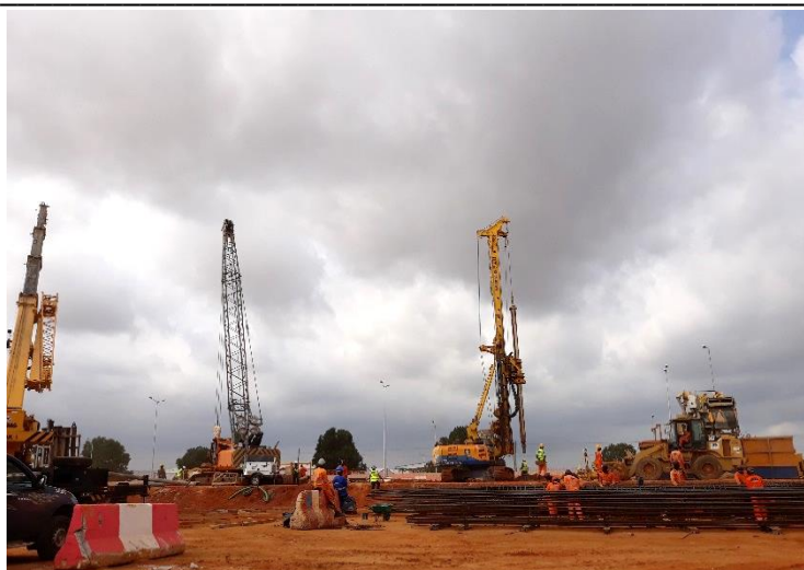
Figura 4.15 – Vista para Norte da obra Viaduto da NAIL
