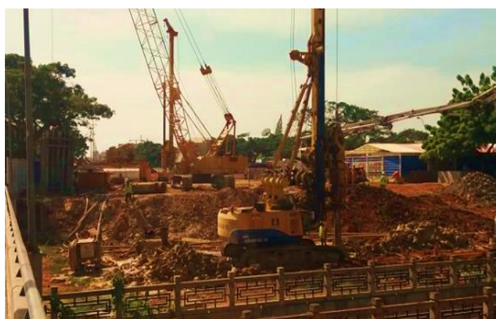
Figura 4.11 – Vista geral para leste da obra Viaduto Deolinda
