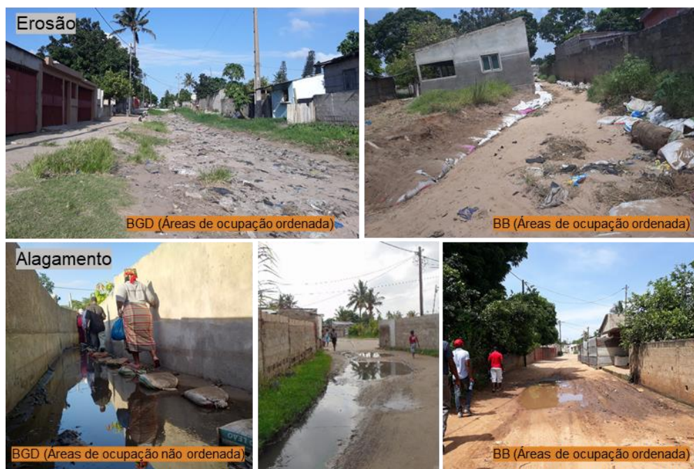
Figura 4.19: Problemas de drenagem no espaço coletivo.
