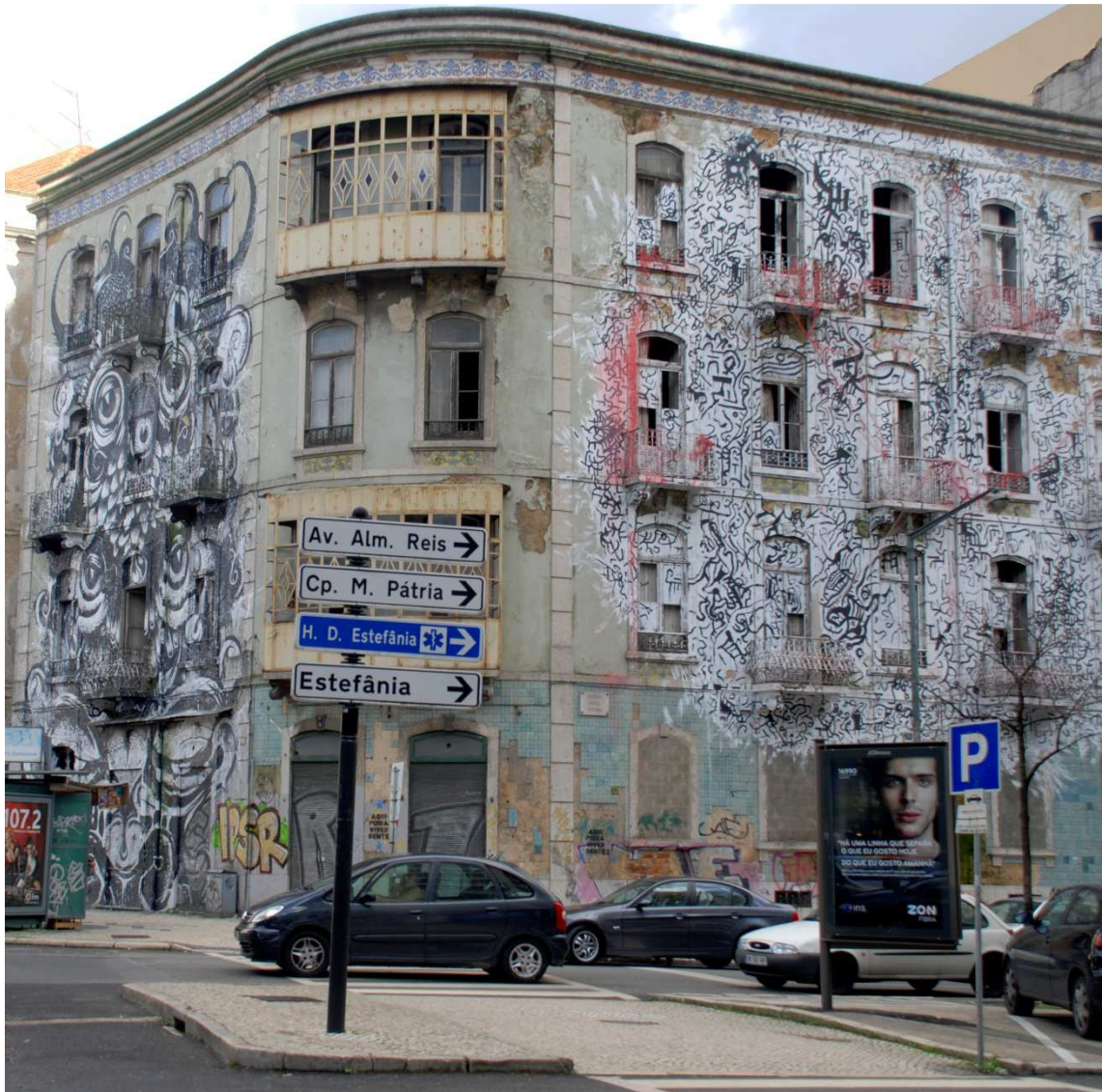
Fig. 28 - Arte urbana realizada em prédio na Praça Duque de Loulé em 2010 hoje já foi demolido. Foto: Bia Pedrosa
