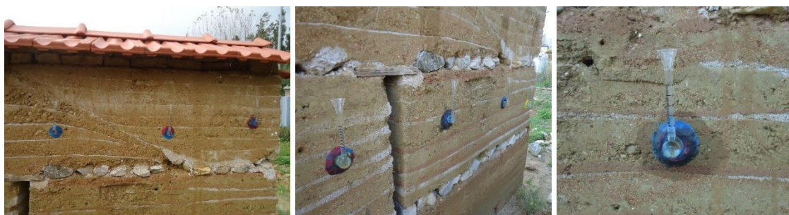
Figura 5.7 – Ensaio de absorção de água sob baixa pressão no murete de taipa através de tubos de Karsten (a, b, c)
