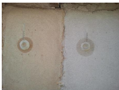
Figura 5.44 – Pormenor de dois tubos de Karsten aplicados no reboco
