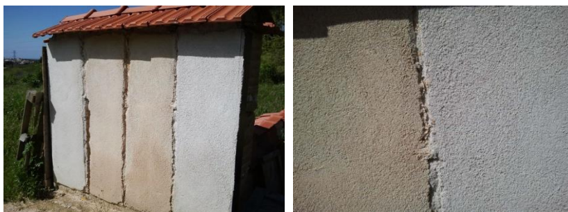
Figura 5.41 – Aspeto do reboco aplicado no murete de taipa aos 90 dias
