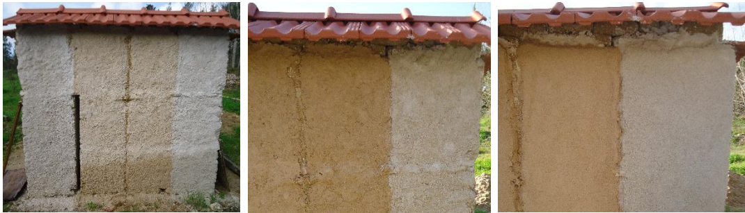
Figura 4.16 – Aspeto geral do murete após aplicação do salpisco (a), acabamento do salpisco (b) e acabamento do reboco final (c)
