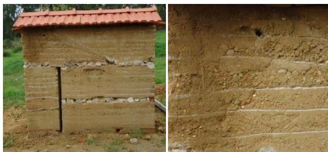
Figura 3.1 – Aspeto geral do murete de taipa
