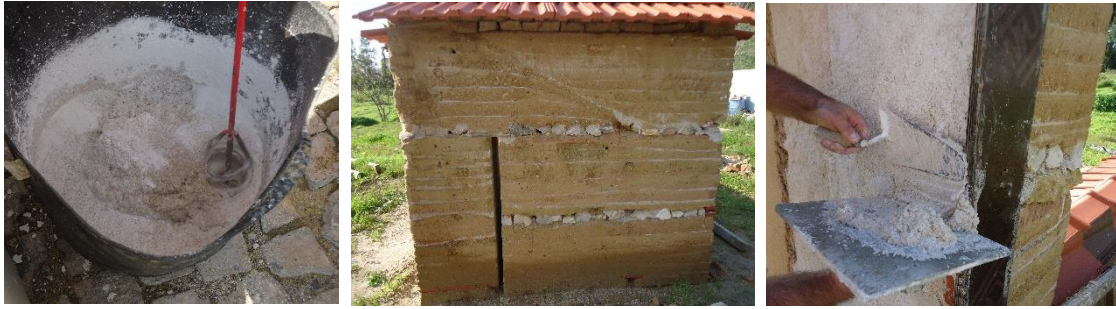
Figura 4.15 – Processo de amassadura com berbequim elétrico (a), níveis de humidade ascendente do solo no murete de taipa (b) e aplicação da argamassa (c)
