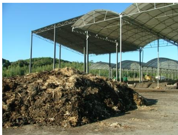
Figura 2.3 – Aspeto de uma central de compostagem em pista coberto (fonte: jornal de notícias “o Almonda”)
