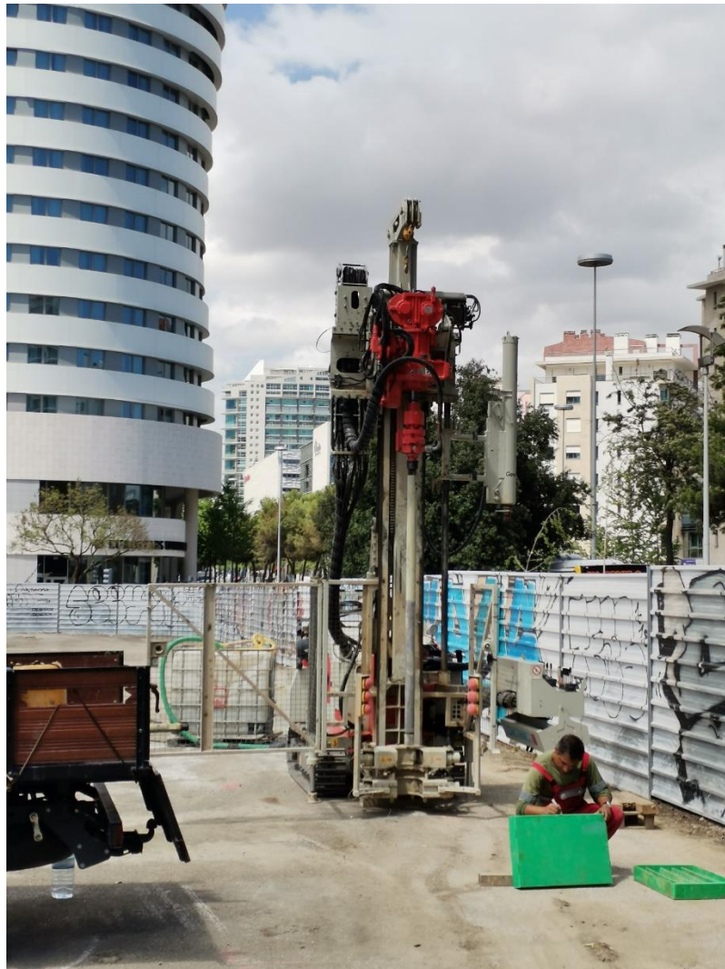
Figura 3.11 – Execução da sondagem SG40.
