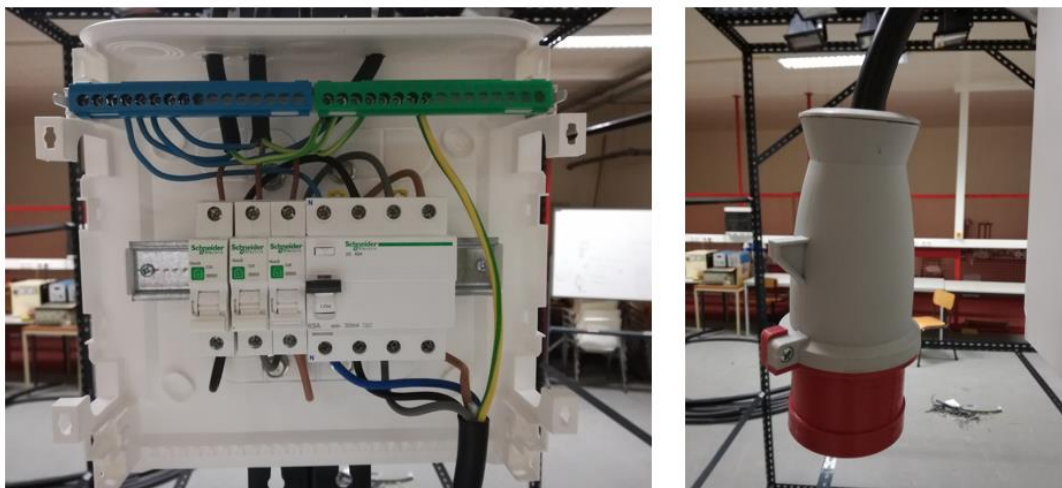
Figura 3.31 - Montagem do quadro e ficha industrial.
