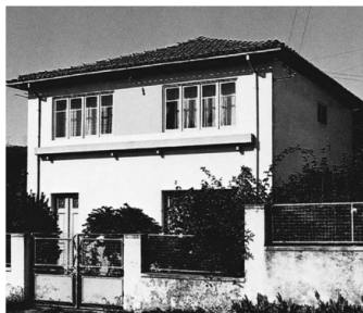
Casa onde se iniciou a atividade do Grupo Vicaima (1959)
