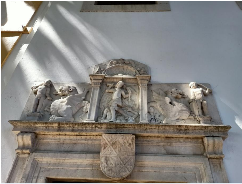
Fig. 11 – Lintel do portal de entrada na capela
