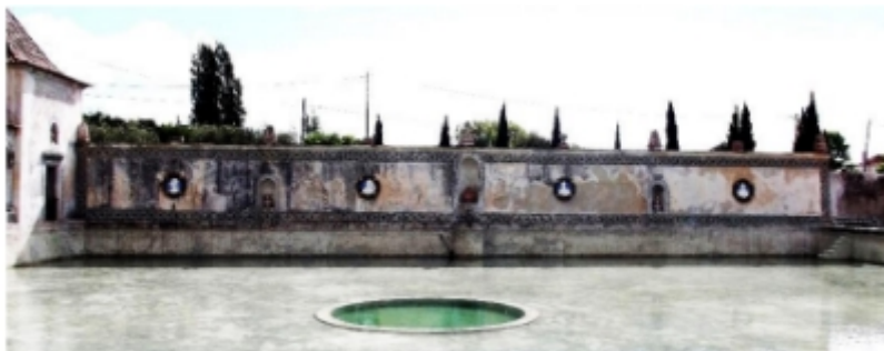
Fig. 59 - Tanque guarda-peixes no fundo do tanque vazio da Quinta da Bacalhoa. Foto retirada de: mia_ana_sousa_dissertacao (1).pdf acedido a 15.05.2022
