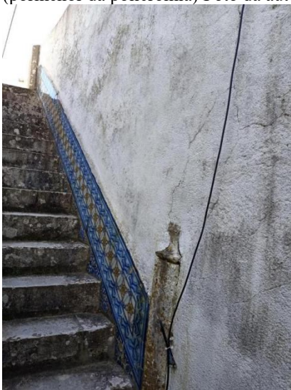
Fig. 16 - Parte do corrimão de acesso ao miradouro embutido no muro exterior. Foto da autora.
