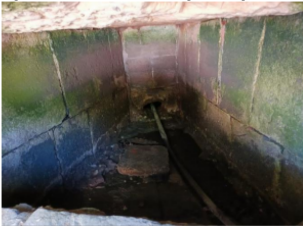
Fig. 63 - Antecâmara de entrada e saída da água das marés. Foto da autora.
