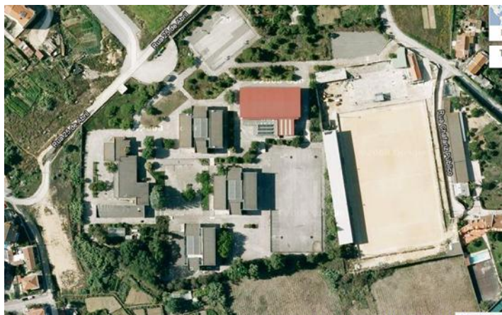
Figura 2. Imagem da escola (ainda sem as obras actuais). Fonte: Google maps
