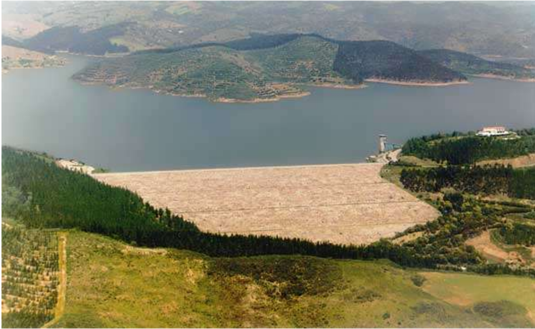
Figura 4.2: Fotografia da Barragem de Santa Clara (fonte: http://cnpqgb.inag.pt )
