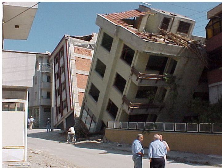
Figura 2.1 - Turquia (1999), liquefacção do solo [6].
