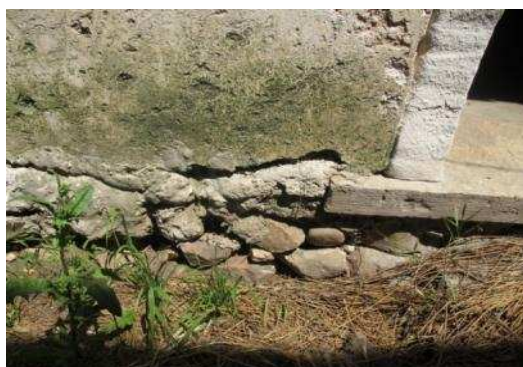
Pormenor das fundações
