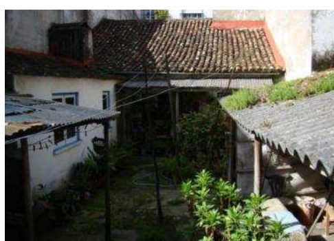
Casa de habitação - logradouro
