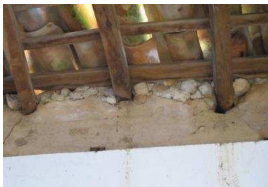
Remate da cobertura sem forra (cozinha)
