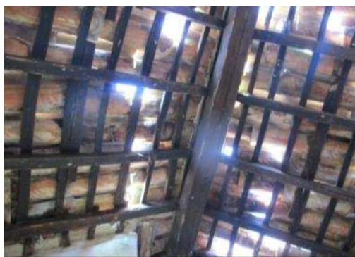
Cobertura sem forra (cozinha)
