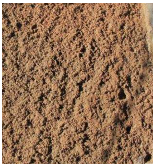
Revestimento - parede exterior (almagra)
