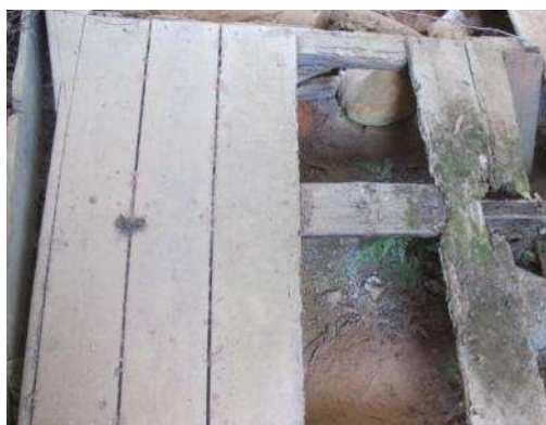
Pavimento de madeira (sala)
