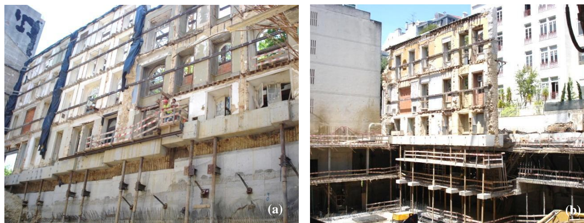
a - Vista de parte do interior da fachada principal ; b - Vista da fachada suspensa por microestacas presente no interior do estaleiro
