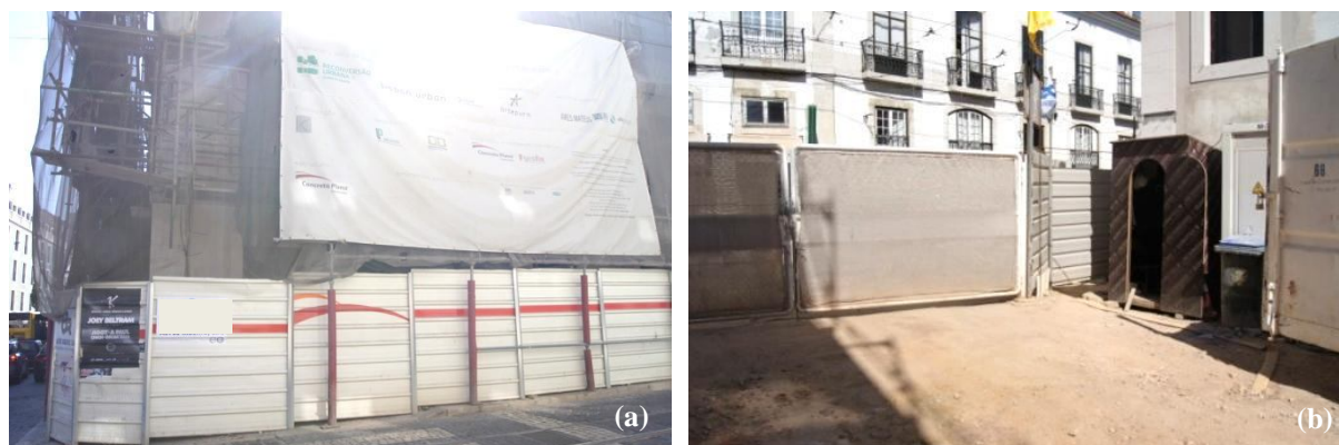
a - Vedação em chapa metálica ; b - Portaria perto das entradas do estaleiro
