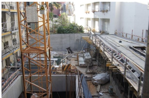
Figura 5.42 - Localização das instalações fixas de produção da obra D.
