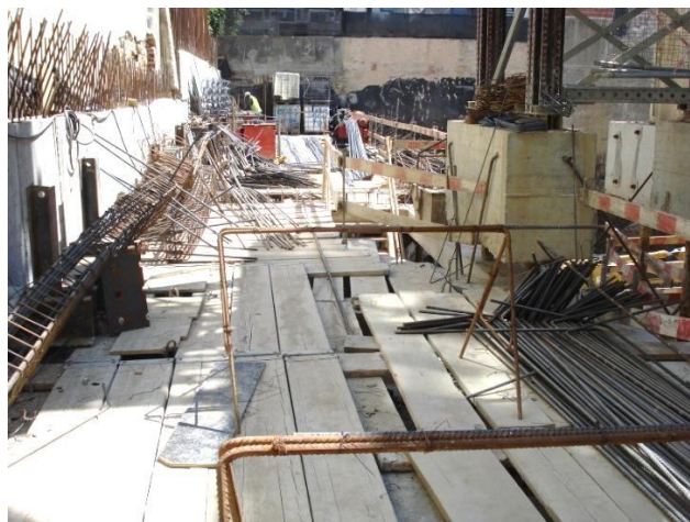
Figura 5.23 - Local da oficina de armaduras na obra B.
