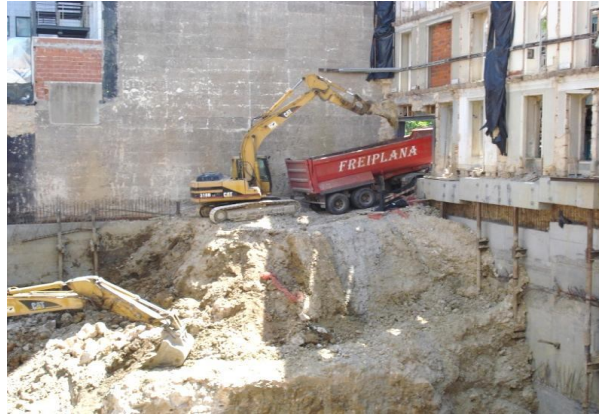
Figura 2.7 - Trabalhos de movimentação de terras com atuação dos manobreadores de equipamentos.
