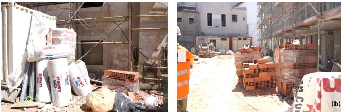
a,b - Zonas de armazenagem de material diverso
