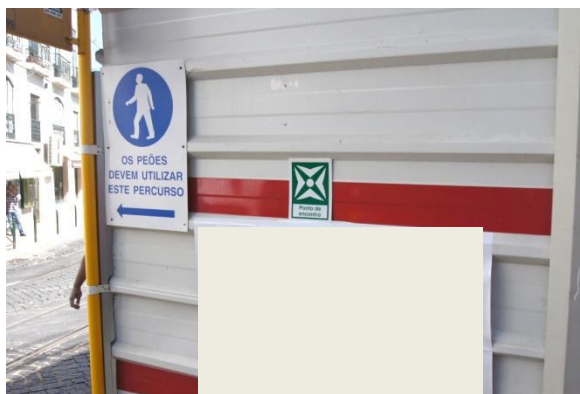
Figura 5.16 - Ponto de encontro da obra A.
