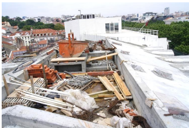
Figura 5.50 - Depósito de cofragens e andaimes na obra D.
