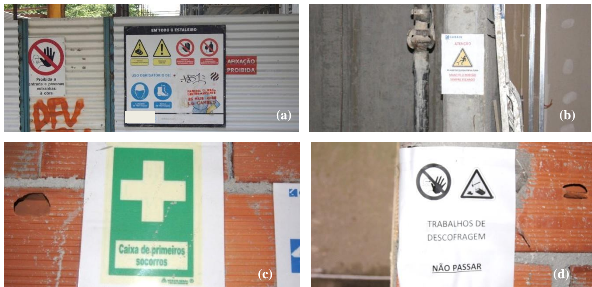
a - Sinalização à entrada do estaleiro ; b - Sinalização de aviso de queda em altura ; c - Sinalização da localização da caixa de primeiros socorros ; d - Sinalização de aviso de trabalhos de descofragem
