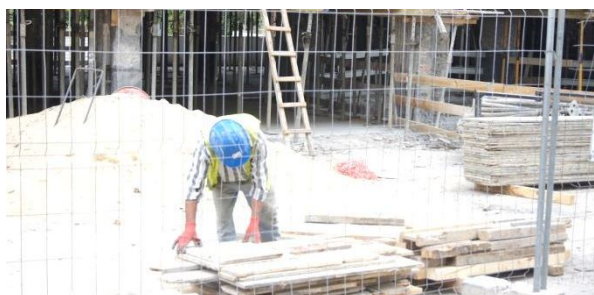
Figura 5.33 - Utilização de EPI na obra C.
