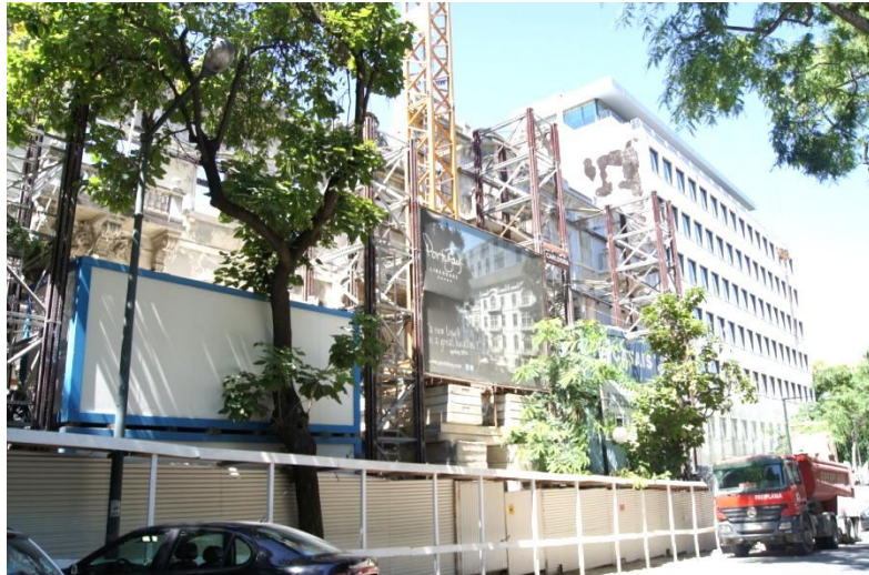
Figura 5.22 - Instalações sociais da obra B.
