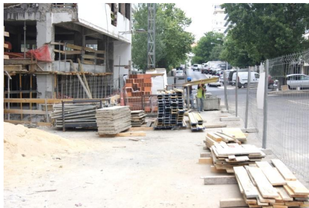
Figura 5.39 - Depósito de cofragens e andaimes na obra C.
