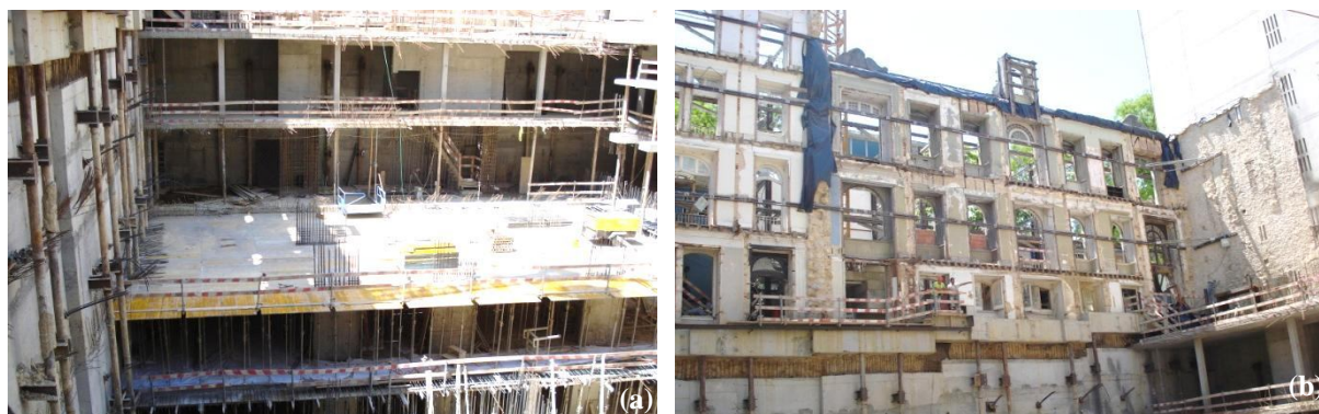
a - Visão geral dos caminhos de circulação sempre com a presença dos guarda-corpos ; b - Corredor de circulação entre as duas entradas ao meio e corredor de circulação de acesso à entrada e saída dos trabalhadores à direita
