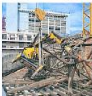
Foto 3 – Robot demolidor de 900Kg
