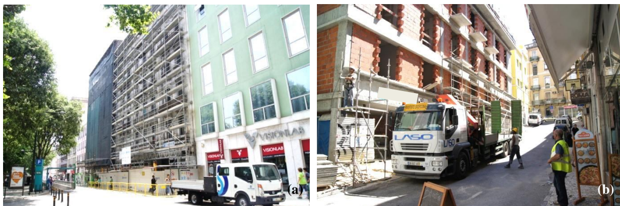
a - Vista de parte da fachada principal ; b - Vista de parte do tardoz
