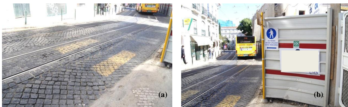
a - Passadeira temporária ; b - Sinalização de encaminhamento de peões
