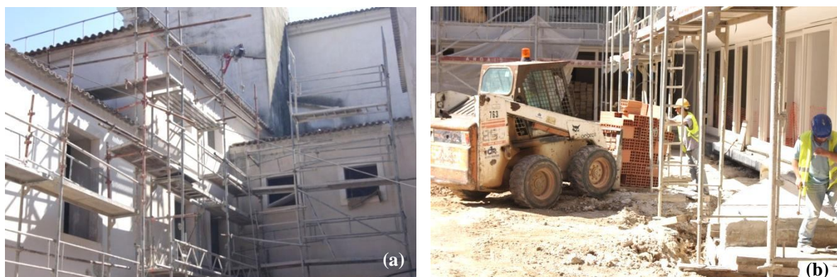
a - Uso de guincho de elevação ; b - Uso de pá-carregadora para transporte
