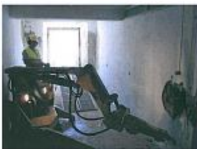
Foto 1 – Robot demolidor de 900Kg
