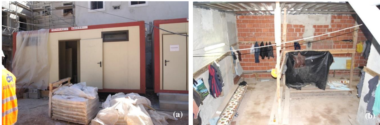
a - Módulos sanitários ; b - Zona do vestiário
