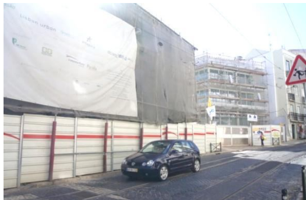
Figura 5.1 - Vista geral da obra A.
