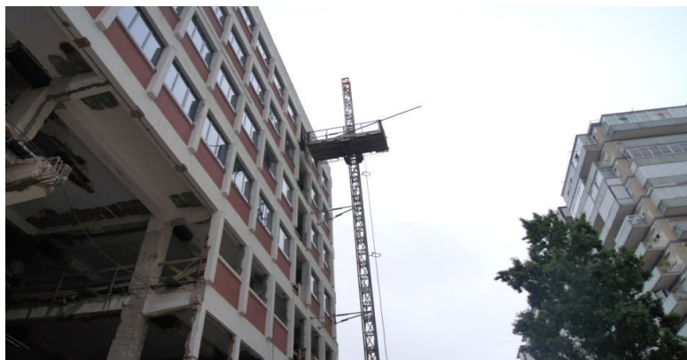
Figura 2.8 - Utilização de ascensor monta-cargas num estaleiro da construção.
