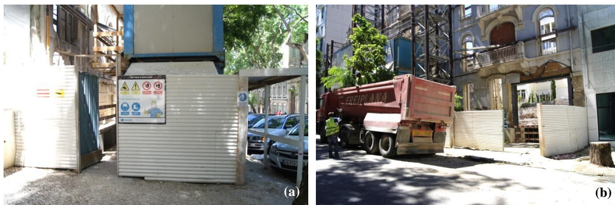
a - Entrada para trabalhadores ; b - Entrada para camiões
