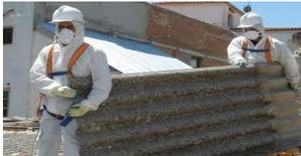
Figura 2.13 - Utilização de equipamento apropriado para a remoção de materiais com amianto (Site “Tribunal Superior do Trabalho”).
