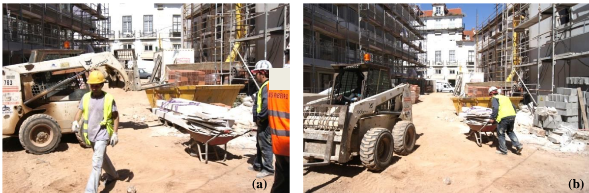
a - Trabalhador a aguardar a passagem da máquina ; b - Trabalhador a ir para zona da ferramentaria depois da máquina se ir embora
