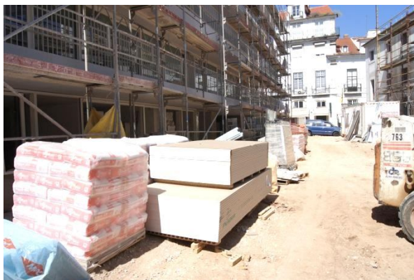
Figura 5.9 - Localização das instalações fixas de produção na obra A.
