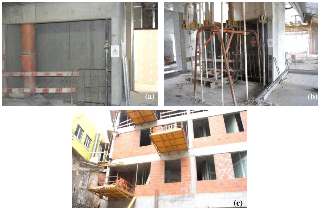
a - Transporte de materiais através da caixa de elevadores ; b - Uso de guincho mecânico de elevação ; c - Uso de plataformas de descarga
