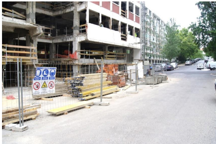
Figura 5.35 - Ocupação de metade de uma rua sem sentido na obra C.
