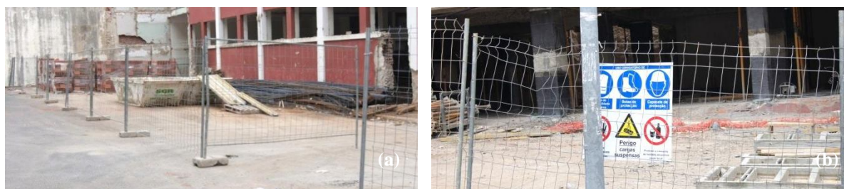
a - Vedação em rede metálica ; b - Desgaste acentuado da vedação em rede metálica
