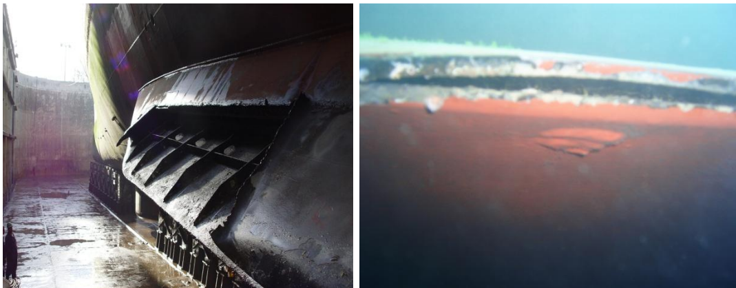
Figura 2.3 Fracturas na extremidade do robalete, na soldadura de ligação entre a placa superior e inferior.
