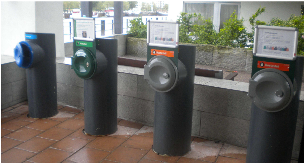
Figura 3.11 – Hammarby Sjöstad: Sistema público de recolha (para reciclagem) de lixo (Foto do autor, 2012).
