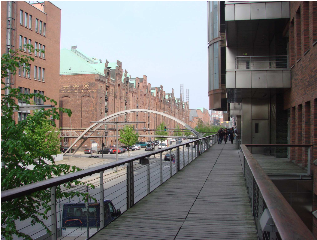
Figura 3.4 – Hafencity: Sistema de circulação pedonal para situações de cheias (Foto do autor, 2011)
