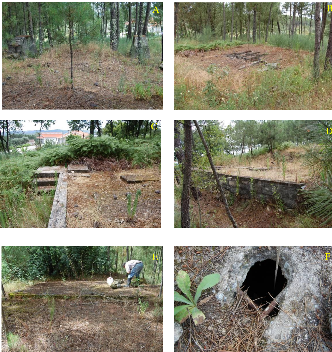
Figura 3.4 Infra-estruturas da antiga mina nas imediações do poço mestre: A – suportes antigos; B, C, D – fundações de um edifício de apoio; E – Laje de cobertura do poço; F – Abertura na laje para inspeção e monitorização.
