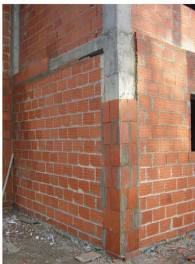
Figura 3.4 – Fotografia que ilustra o revestimento dos pilares (cedido pelo professor doutor João José Lopes de Carvalho)
