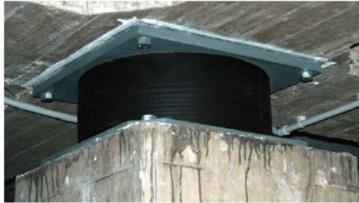
Figura 2.10 – Aplicação de um sistema HDRB em obra (Freyssinet, 2020)
