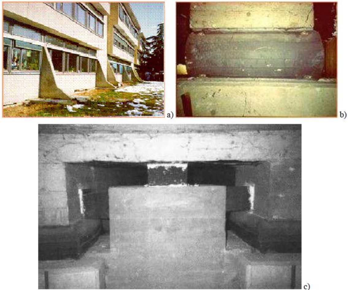
Figura 2.4 – a) Escola Heinrich Pestalozzi, em Skopje; b) Bloco de borracha não reforçado; c) Blocos fusíveis em porcelana (Guerreiro, 2003).
