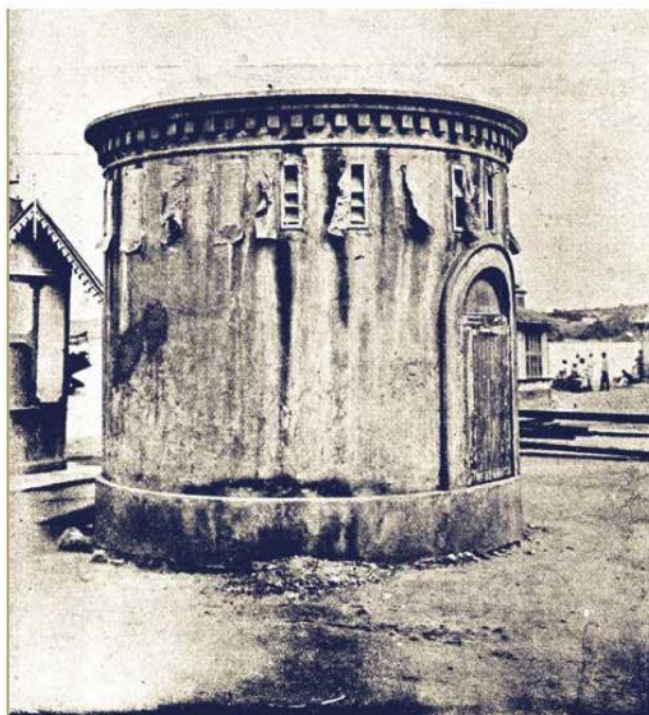
Figura 5-16: Um dos tanques auxiliares do primeiro sistema de esgoto de Vitória
