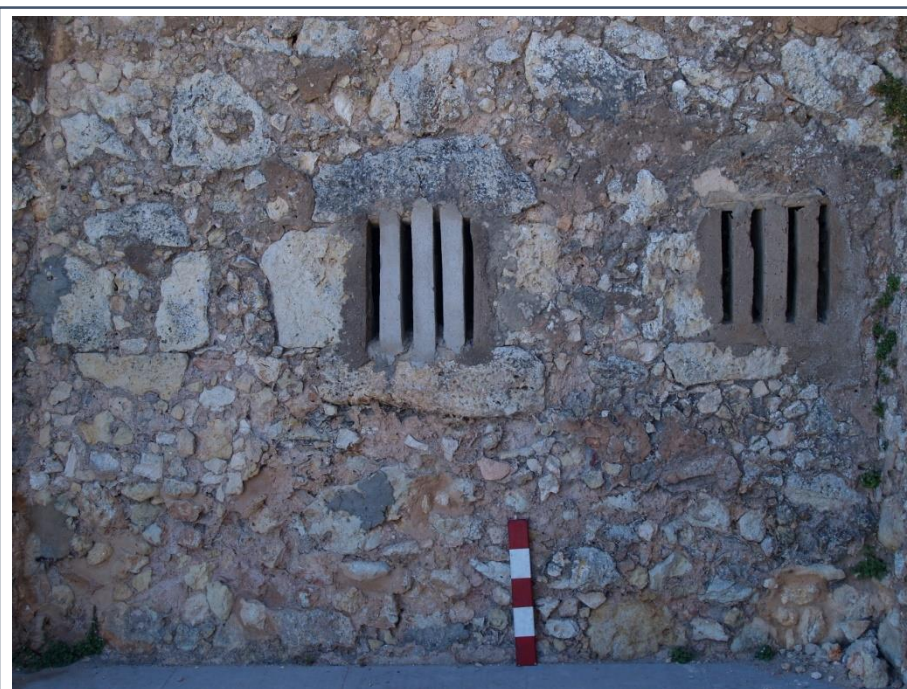
Figura 69 – Da esquerda para a direita, a boca-de-fogo com UEM [19] com o preenchimento UEM [20], a boca-de-fogo com UEM [21] com o preenchimento UEM [22] e por fim a boca-de-fogo com UEM [23] com o preenchimento UEM [24]. ©Bruna Galamba, 2021.
