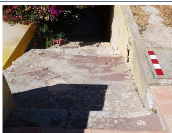
Figura 117 – Nesta fotografia é possível observar a inclinação das escadas a Este.
