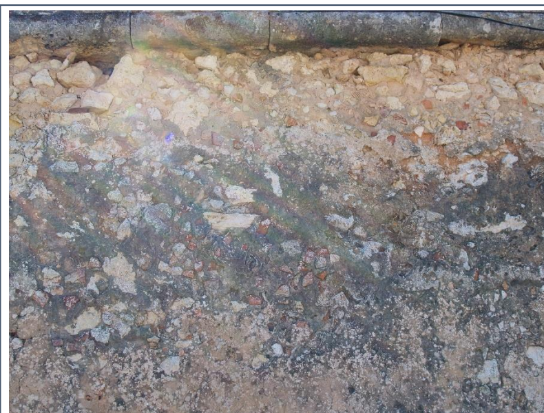
Figura 64 – A UEM [10] é um remendo em argamassa cinzenta ou com cimento, com inclusões de cerâmica de construção, localizado apenas no meio-baluarde Este. ©Bruna Galamba, 2021.
