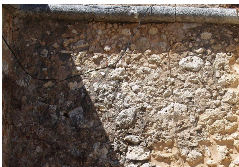
Figura 74 – A UEM [30] é representada pela argamassa ou cimento com inclusão de pedras. ©Bruna Galamba, 2021.
