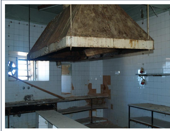
Figura 98 – A cozinha instalada dentro do meio-baluarde Oeste. ©Bruna Galamba, 2021.
