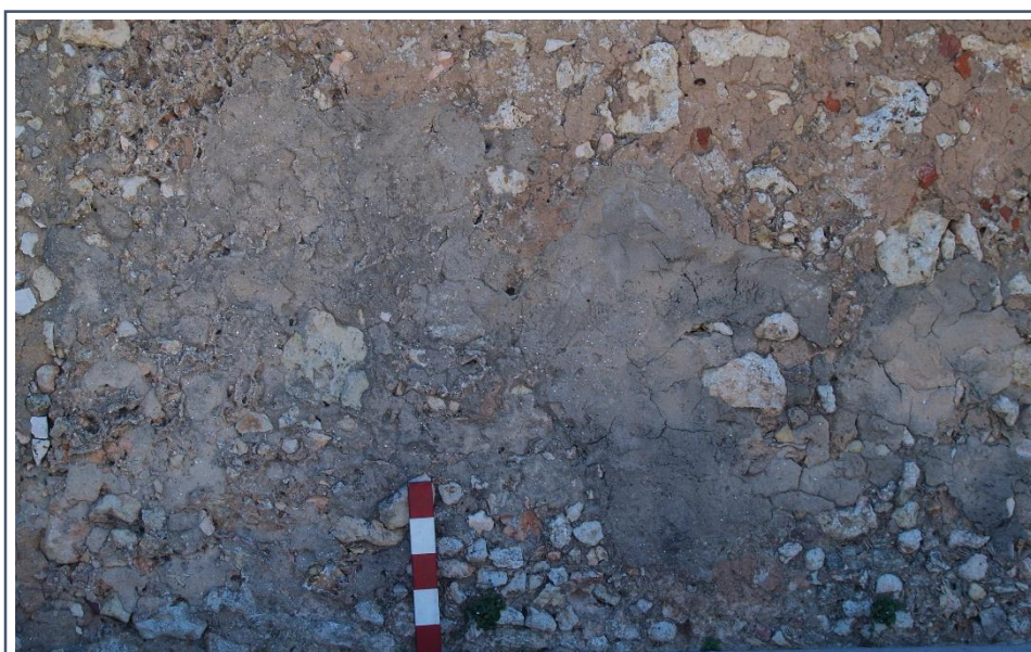
Figura 62 – A UEM [8] é um remendo em cimento, localizado apenas no meio-baluarde Este. ©Bruna Galamba, 2021.
