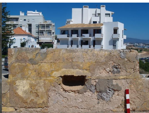
Figura 103 – Reforço de tijolo e cimento nas canhoneiras e merlões, no piso superior do meio-baluarte Este. ©Bruna Galamba, 2021.
