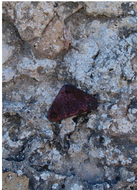
Figura 114 – Nesta fotografia é possível observar um dos vários elementos férreos espalhados pela Fachada Norte.
