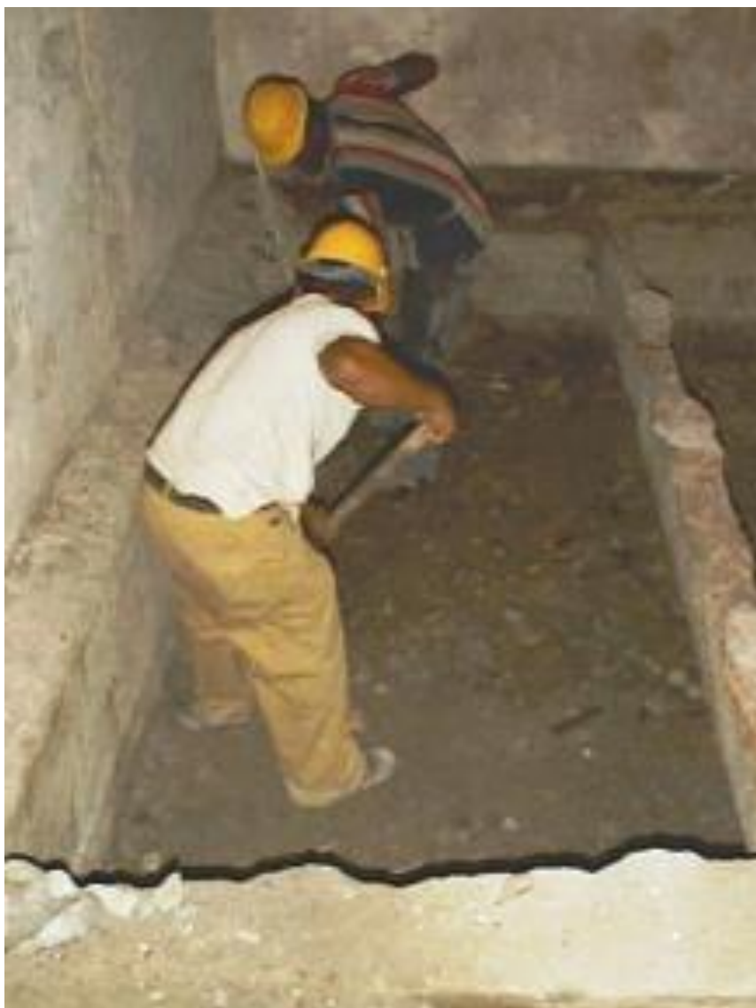
Figura 49: Excavação da zona noroeste do Claustro, Setor E (DÍAZ, s.d.).
