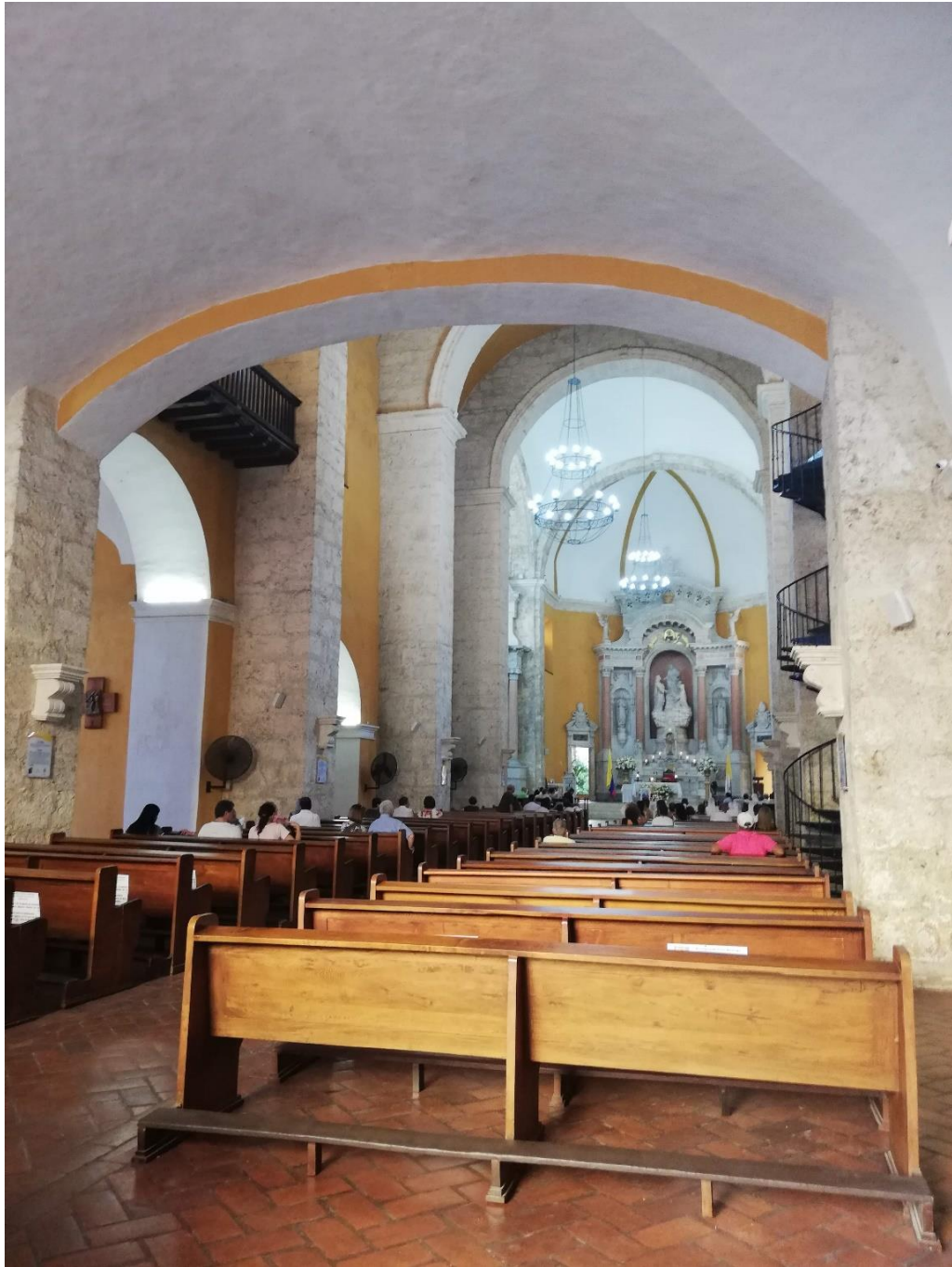
Figura 29: Interior da Igreja de Santo Domingo (Fotografia da Autora, 2019).
