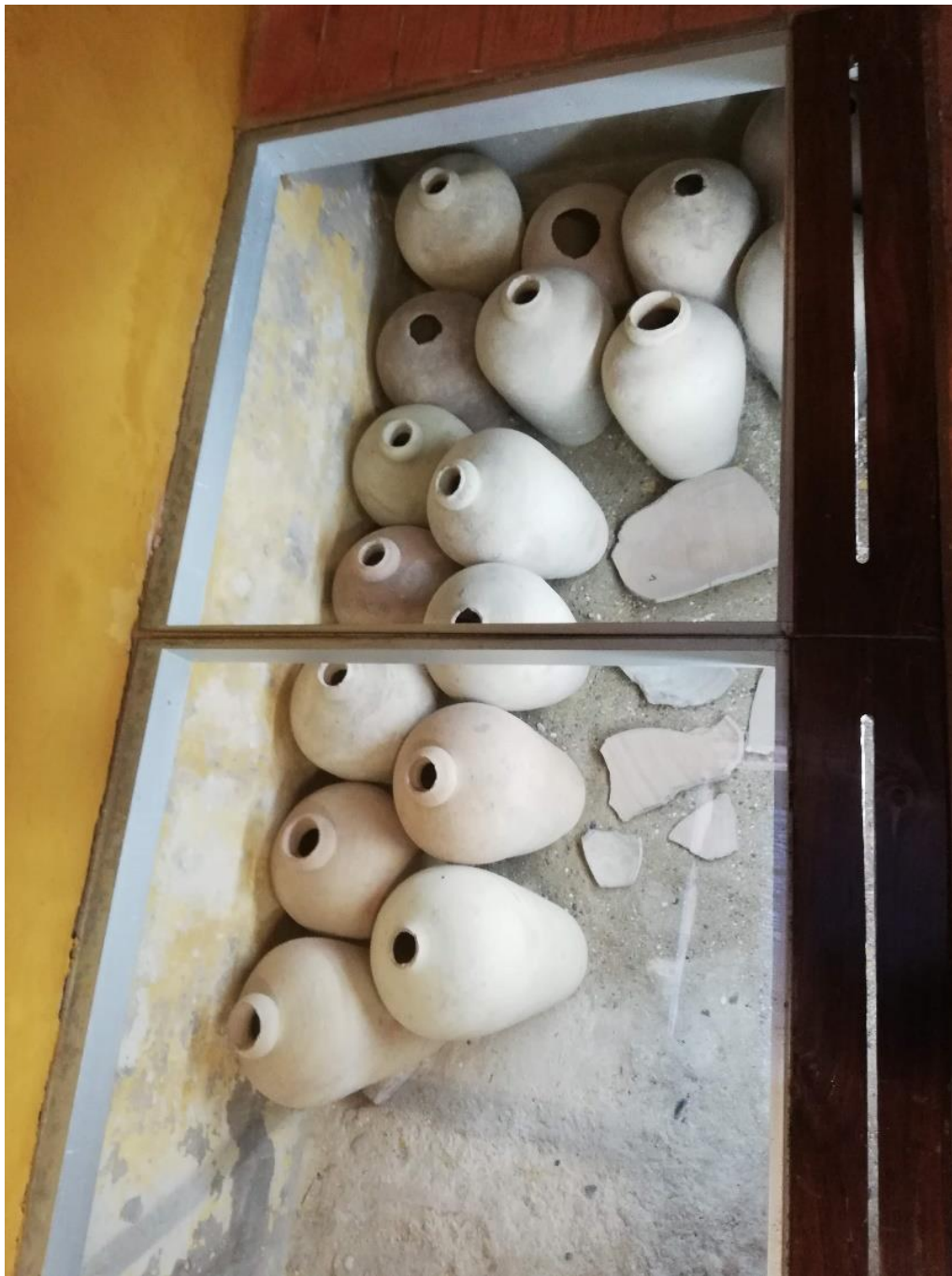
Figura 33: Conjunto de botijas que compunha o enchimento das abóbodas do piso inferior musealizadas e colocadas na sua posição original (Fotografia da Autora, 2019).
