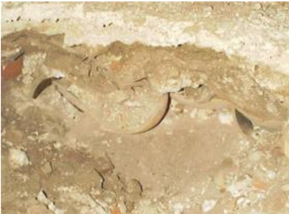
Figura 56: Pormenor do enchimento das abóvedas do piso térreo com material cerâmico (DÍAZ, s.d.).
