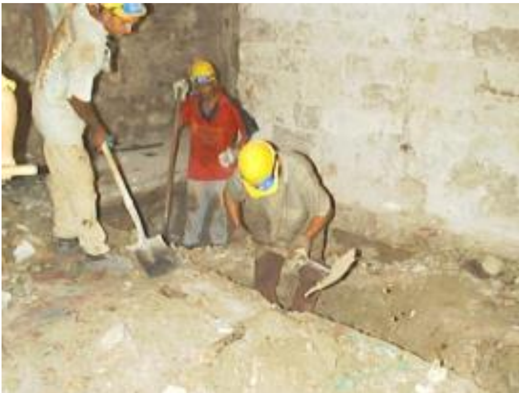
Figura 59: Acompanhamento de obra (DÍAZ, s.d.).
