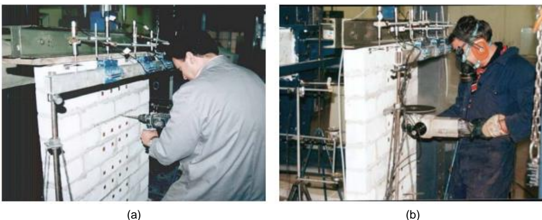
(a) realização do corte utilizando um berbequim; (b) realização do corte utilizando uma serra circular
