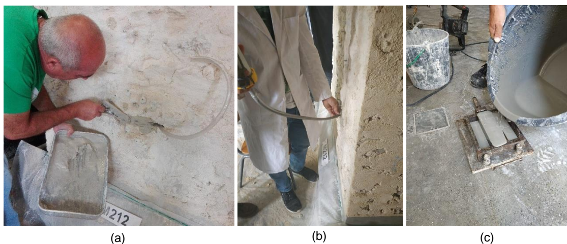
(a) aplicação de gesso; (b) injeção de calda de cimento; (c) provetes de calda de cimento
