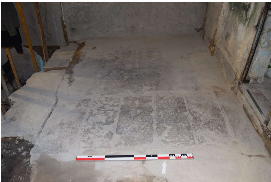
Fotografia 1 – Pavimento hidráulico composto por cimento e lajes calcárias na zona do saguão.
