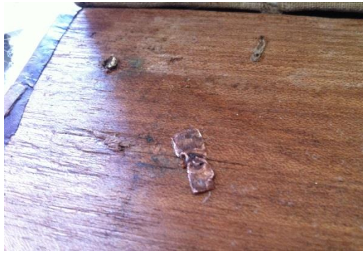
Figura VI.6 - Recolocação dos elementos metálicos
