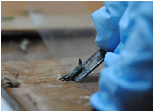
Figura VI.5 - Levantamento dos rebites
