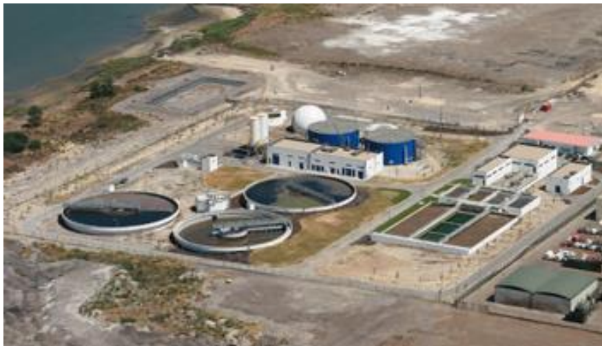
Figura 5.4 – Vista aérea da ETAR do Seixal (Fonte: SIMARSUL, 2015)
