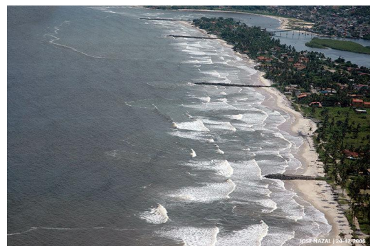
Figura 6- Erosão no início da Rodovia Ilhéus-Itacare e Figura 7-Foto dos espigões do São Miguel. Fonte: Blog Pimenta, 2021
