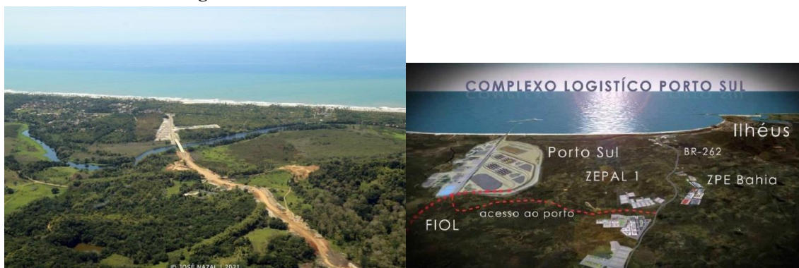
Figura 28-Construção do acesso ao Porto Sul. Fonte José Nazal, 2021 e Figura 29-Localização do Complexo Porto Sul e ZPE em relação a sede de Ilhéus. Fonte: https://www.otabuleiro.com.br/blog/setores-da-prefeitura-de-ilheus-iniciam-planejamento-de-acoes-na-area-do-porto-sul de 2019. Acesso em 16/08/2021.
