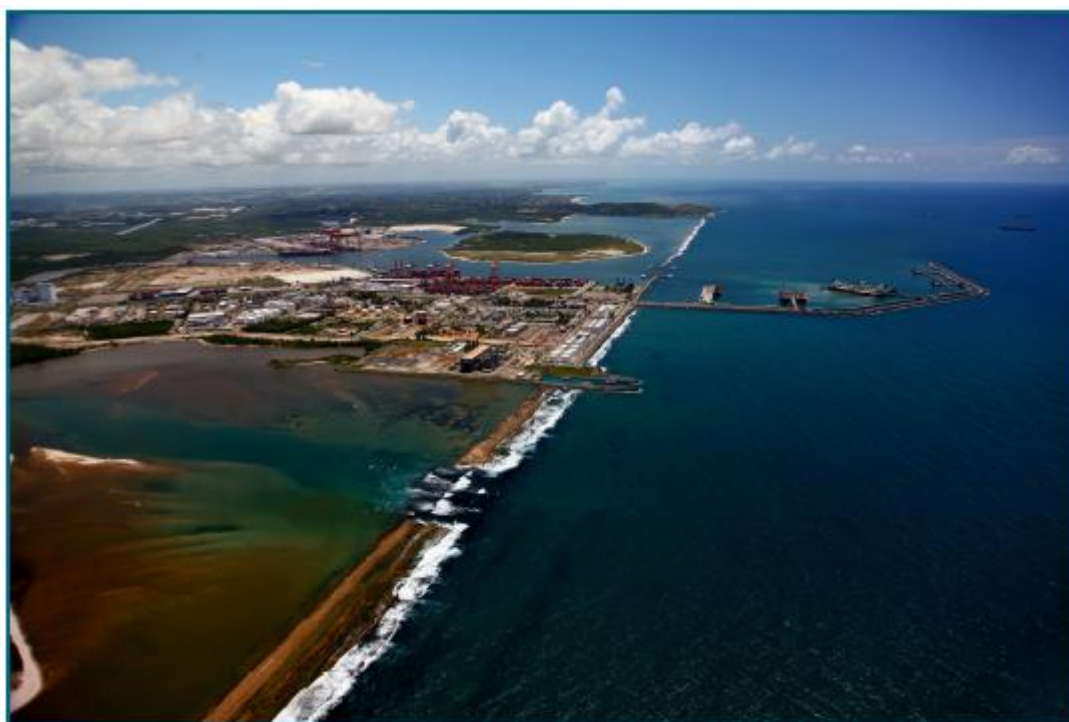
Figura 37-Infraestrutura do Porto de Suape (PE), sobre os ecossistemas da foz do Rio Ipojuca e barreiras de coral. Fonte: Gustavo Penteado (s/d).
