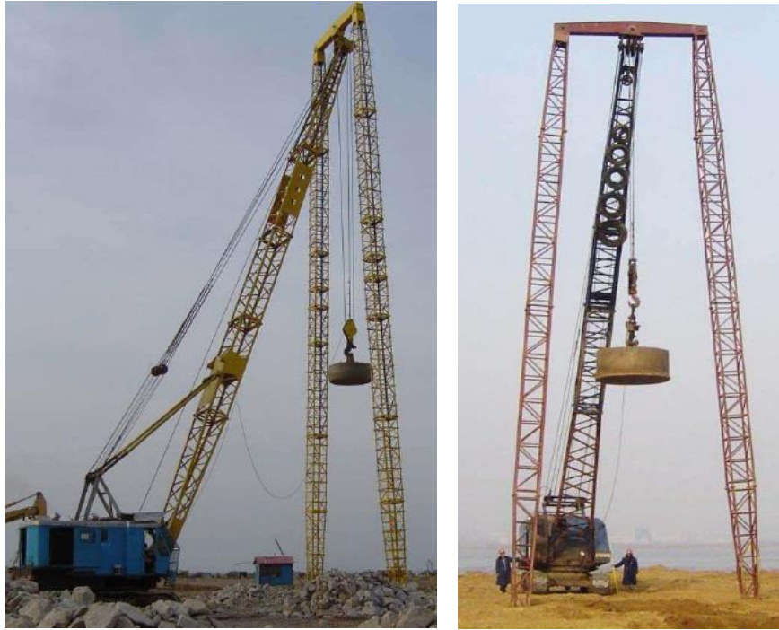
Figura 2.10 - Compactação dinâmica na China usando guas convencionais alteradas para tripés (Hamidi, 2014).
