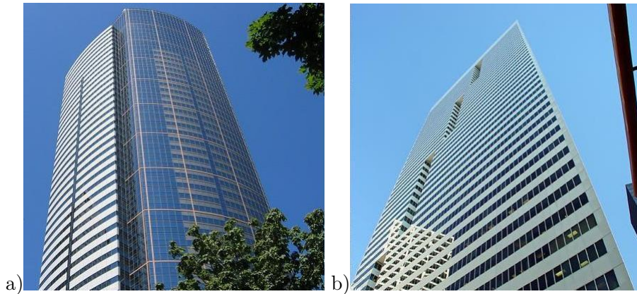
Figura 1.3: Exemplos de edifícios construídos com colunas mistas: First City Tower (a) e Two Union Square (b) (fonte Wikipedia ).
