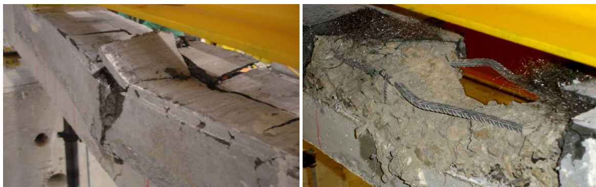
Figura 6.43 Rotura do modelo reforçado por encamisamento com CRFU
