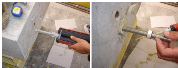
Figura 5.16 Fixação dos varões roscados com agente de aderência
