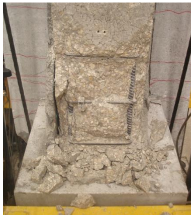
Figura 6.65 Modo de rotura do Modelo VPEE - Alçado frontal na zona crítica
