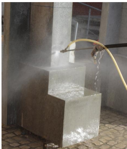
Preparação da superfície com jacto de areia e água
