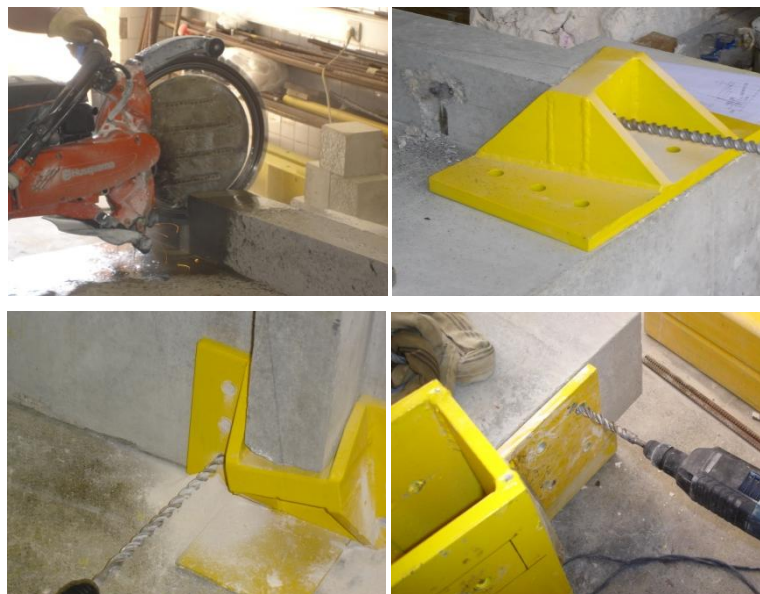
Figura 5.15 Corte da laje e execução dos furos para passagem do cordão e fixação dos ferrolhos de ligação às chapas de ancoragem
