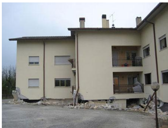
Figura 2.8 Colapso de um edifício devido irregularidade em altura - “soft-storey” - ( L’Aquila 2009) [Fajfar (2010)]
