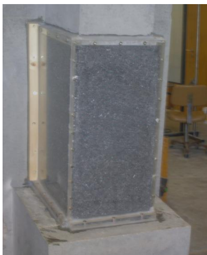
Colocação da cofragem
