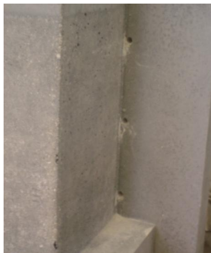
Execução dos furos para realização da betonagem
