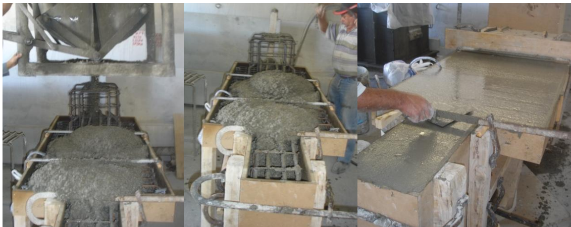
Figura 3.31 Betonagem dos modelos experimentais
