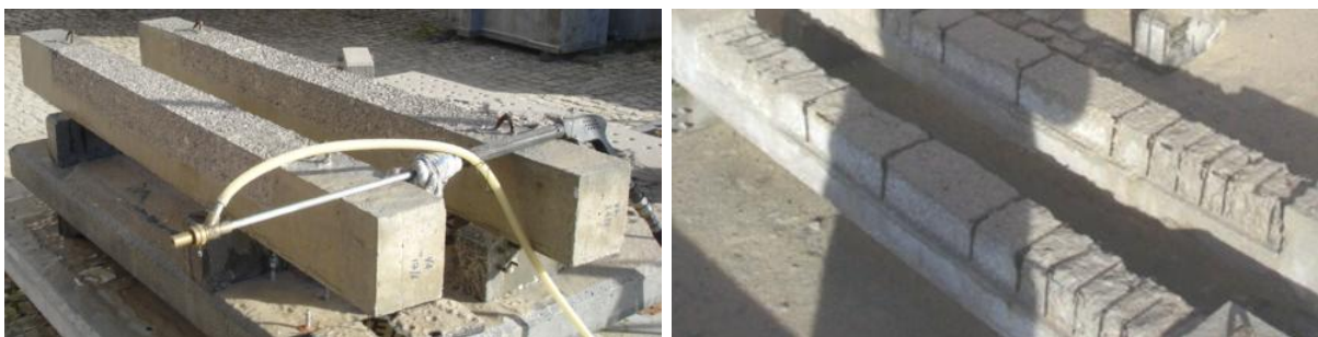
Preparação da superfície com jacto de areia e água
