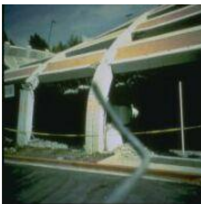
Figura 2.6 Colapso de um edifício pré-fabricado (Northridge 1994) [GeoHazard Images and Movies]
