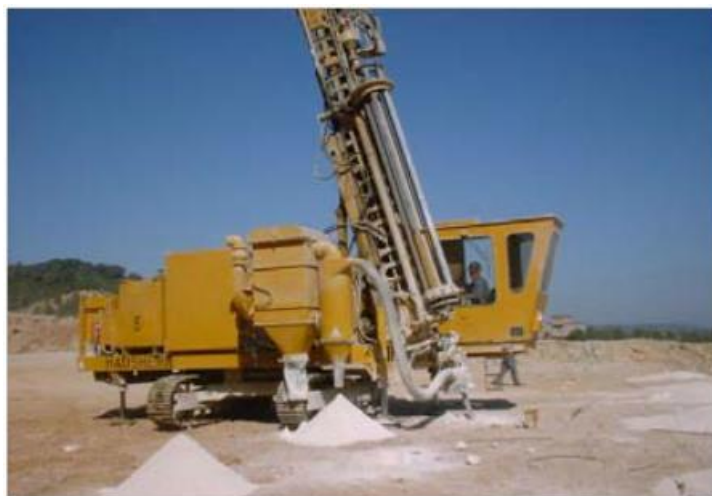
Figura 3.7: Exemplo de máquina utilizada para a realização de furos para a colocação de carga explosiva (Fonte: SECIL, 2011)
