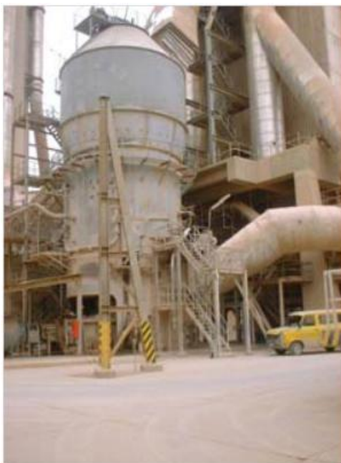
Figura 3.9: Aspecto exterior de um moinho de cru vertical (Fonte: SECIL, 2011).
