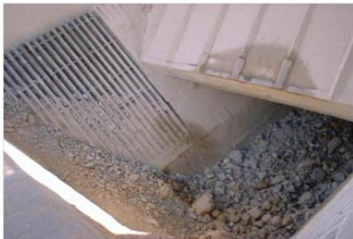
Figura 3.8: Entrada da matéria-prima no britador (Fonte: SECIL, 2011).
