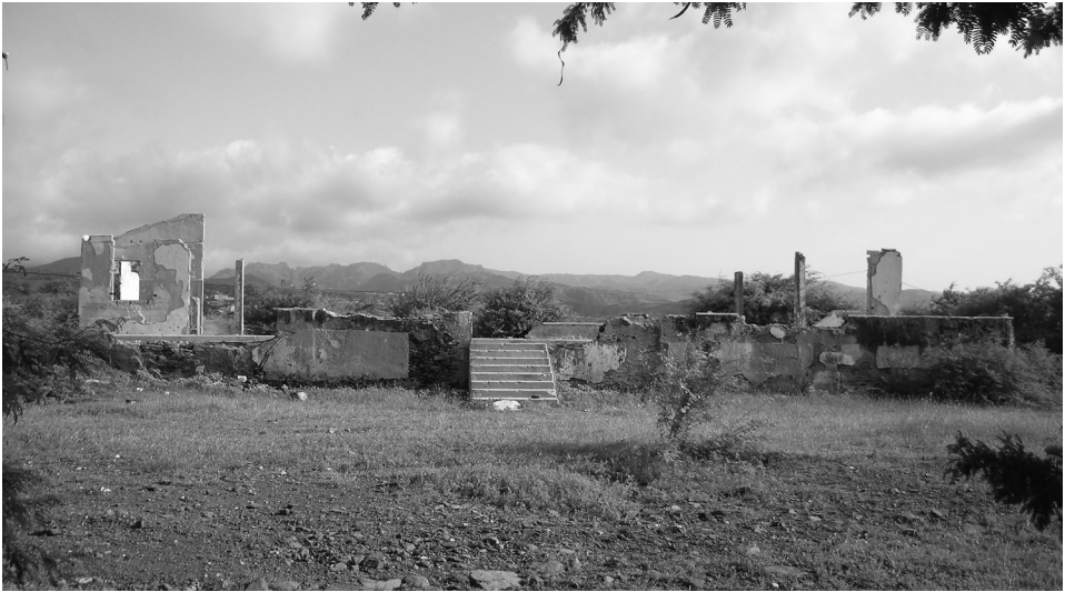
Fig. 4 – Existem na zona envolvente construções com menor interesse como testemunhos que importará integrar no programa de recuperação do sítio. Tal é o caso do edifício da antiga “messe de oficiais”, cujo reaproveitamento poderá contemplar a instalação de serviços acessórios no âmbito de um programa global a definir.
