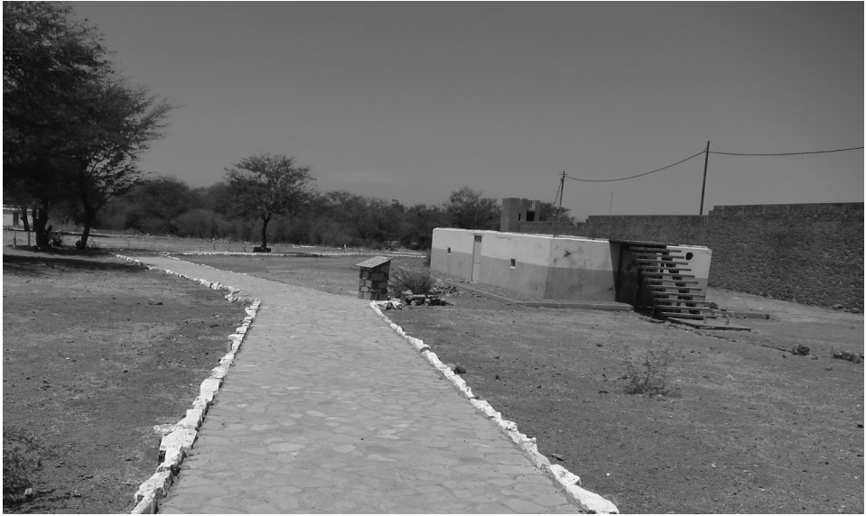
Fig. 6 – Estado actual do edifício da antiga secretaria, posteriormente instalação de um centro interpretativo. Junto foi colocado um painel de identificação.
